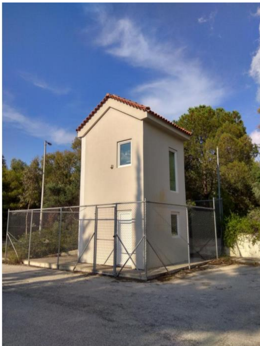
Εικόνα 1.1: Το μελετηθέν κτήριο Mockup εξωτερικά
