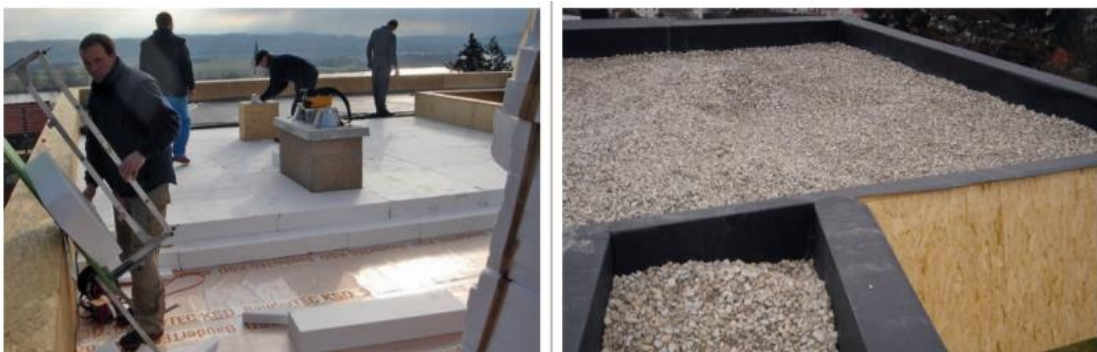
Εικόνα 4.12 Κατασκευή επίπεδης οροφής από CLT
