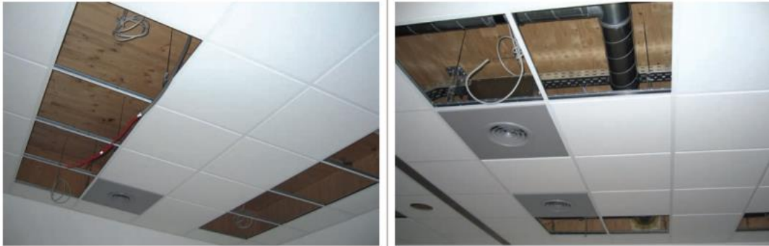
Εικόνα 4.10 Εγκατεστημένο ταβάνι από CLT με ψευδοροφή
