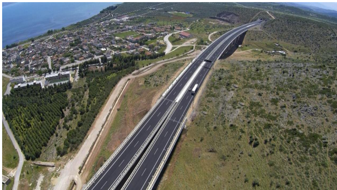
Εικ.22. Τμήμα του Αυτοκινητόδρομου Α1 στο Πέταλο του Μαλιακού. Παράκαμψη Αγίου Κωνσταντίνου. Πηγή: https://www.metaforespress.gr/autokinitodromoi/στα-543-εκατ-τα-έσοδα-διοδίων-στον-αυτοκι/ [Ημερομηνία πρόσβασης: 16/01/2021]
