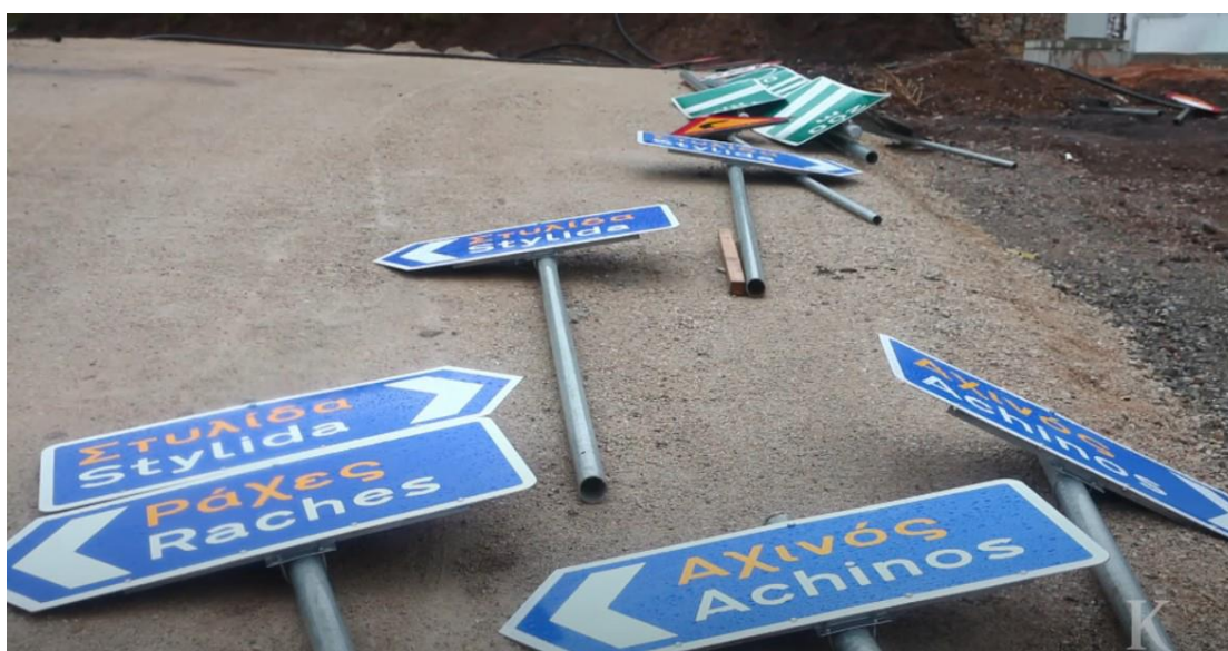
Εικ.23. Κατά την τοποθέτηση σήμανσης στον Αυτοκινητόδρομο Α1.
