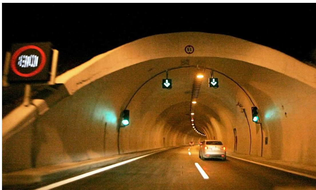
Εικ.30. Η διδυμη σήραγγα Κνημίδος που παρακάμπτει τον Άγιο Κωνσταντίνο. Σημειώνεται ότι στο τμήμα του Α1 που διατρέχει το Πέταλο του Μαλιακού είναι κατασκευασμένες συνολικά 8 σήραγγες διπλού κλάδου. Πηγή: https://www.kathimerini.gr/society/780509/to-polydapano-petalo-maliakoy-kai-oi-kathysteriseis/ [Ημερομηνία πρόσβασης: 20/02/2021]
