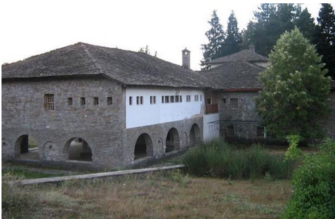
Κτίριο Μαθητικής Εστίας Τσεπελόβου
