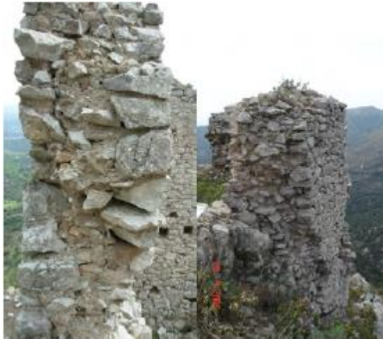
Εικόνα 13. Χαρακτηριστικό παράδειγμα τρίστρωτης λιθοδομής [Adami Ch, 2011]
