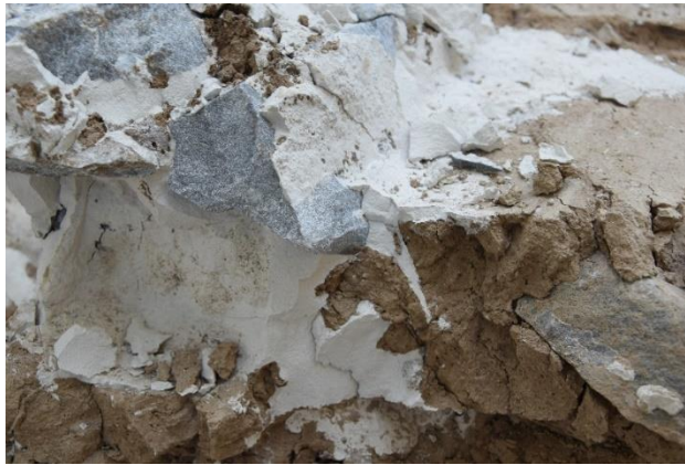
Εικόνα 119. Συνάφεια λίθων- ενέματος- κονιάματος
