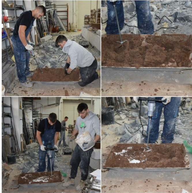
Εικόνα 22. Φωτογραφίες από την παρασκευή του πηλοασβεστοκονιάματος.
