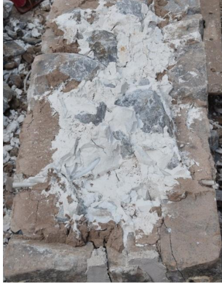
Εικόνα 123. Συγκέντρωση ενέματος στην ενδιάμεση στρώση για τον τοιχίσκο ΤΑΠΙ
