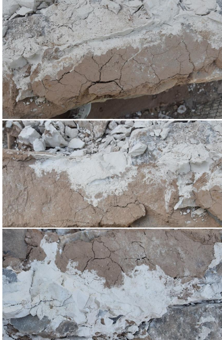
Εικόνα 1171. Τυπικές εικόνες μη πληρωμένων ή εν μέρει πληρωμένων ρωγμών από το ένεμα στον τοιχίσκο ΑΠΙ
