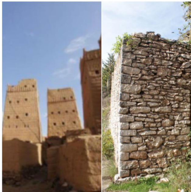
Εικόνα 1. Χρήσεις του πηλού σε παραδοσιακές κατασκευές
