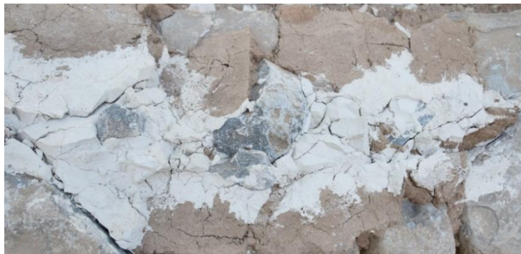
Εικόνα 116. Συγκέντρωση ενέματος στο κέντρο της τοιχοποιίας και ισχυροποίηση διεπιφανειών στρώσεων
