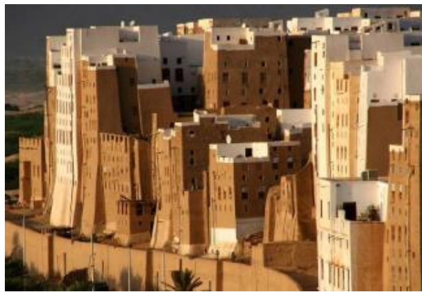
Εικόνα 3. Οκταώροφα κτίρια κατοικιών, 500 χρόνων, από ωμόπλινθους στο Shibam της Υεμένης [Πιτυτζόγια Α., 2014]
