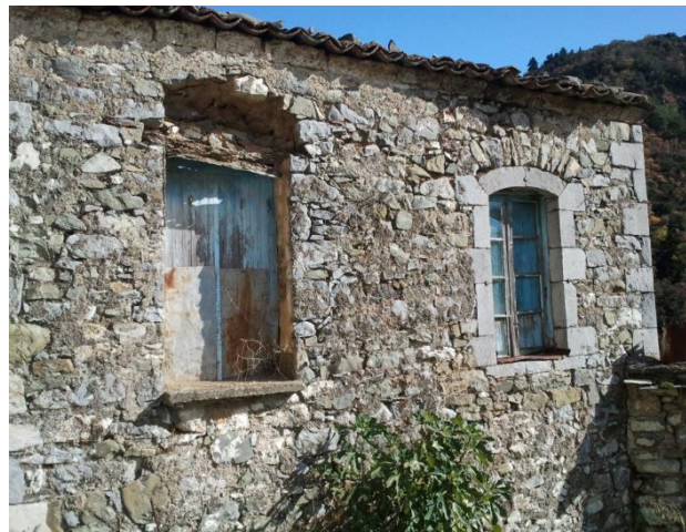
Εικόνα 15. Χαρακτηριστικό παράδειγμα αργολιθοδομής
