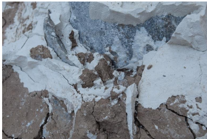
Εικόνα 118. Ενδεικτικό δίκτυο ενέματος στον τοιχίσκο ΤΑΠΙ
