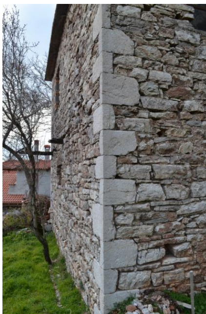
Εικόνα 16. Χαρακτηριστικό παράδειγμα ημιλαξευτής λιθοδομής με λαξευμένους γωνιόλιθους
