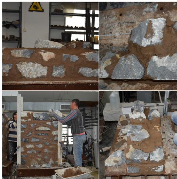
Εικόνα 44. Φωτογραφίες από την κατασκευή σε στάδια των δίστρωτων τοιχίσκων
