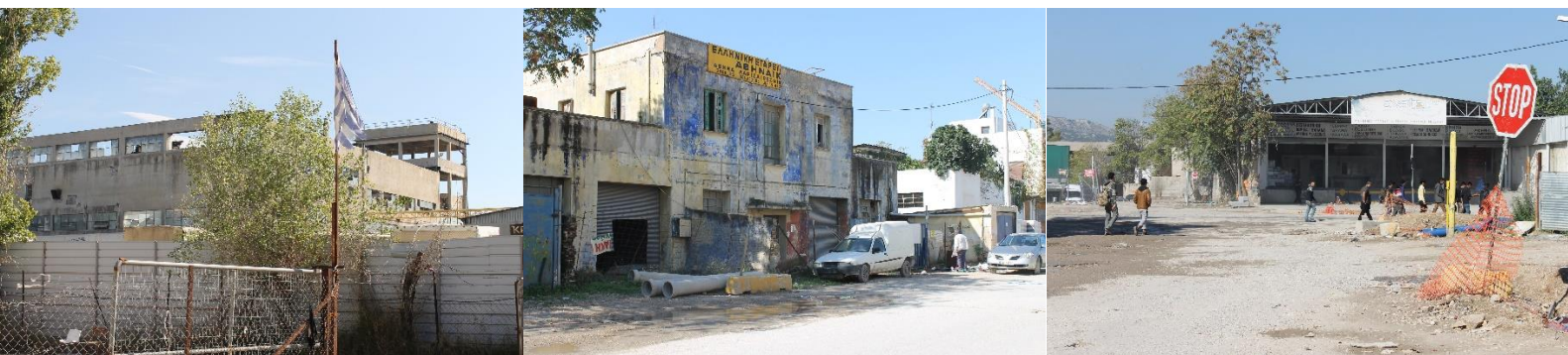
Εικ.29, 30, 31 Η ευρύτερη περιοχή γύρω από το κέντρο υποδοχής στον Ελαιώνα
