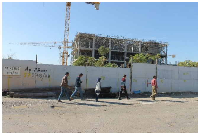
Εικ. 33 Η ανολοκλήρωτη κατασκευή του εμπορικού κέντρου
