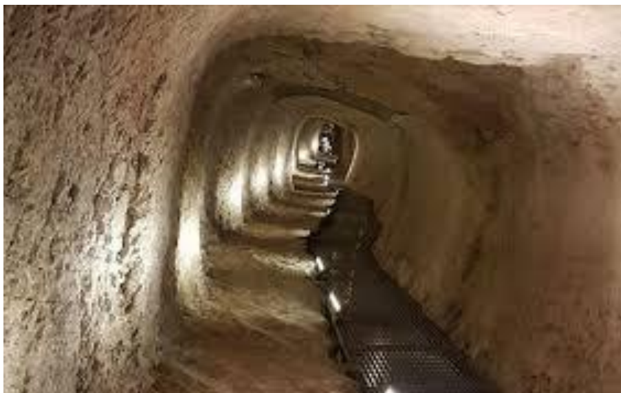
Εικόνα 2. 1, Ευπαλίνειο όρυγμα (Πηγή: naftemporiki.gr )
