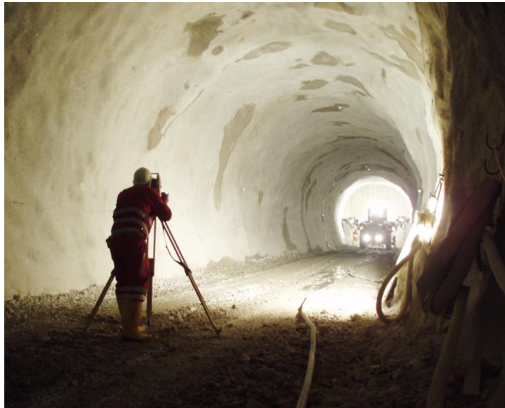
Εικόνα 3 2. Τοπογραφική παρακολούθηση των συγκλίσεων της σήραγγας (Πηγή: Geodata).
