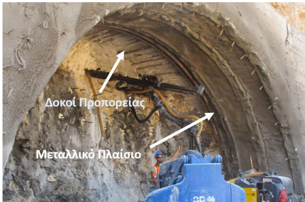
Εικόνα 6. 4. Τρόπος στήριξης ομπρέλας δοκών προπορείας (Πηγή: Ramco Engineering Ltd.).
