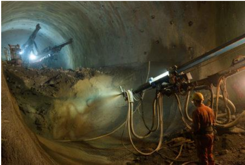
Εικόνα 3 1. Κατασκευή τελικού ανάστροφου τόξου (final invert) (Πηγή: Geodata).
