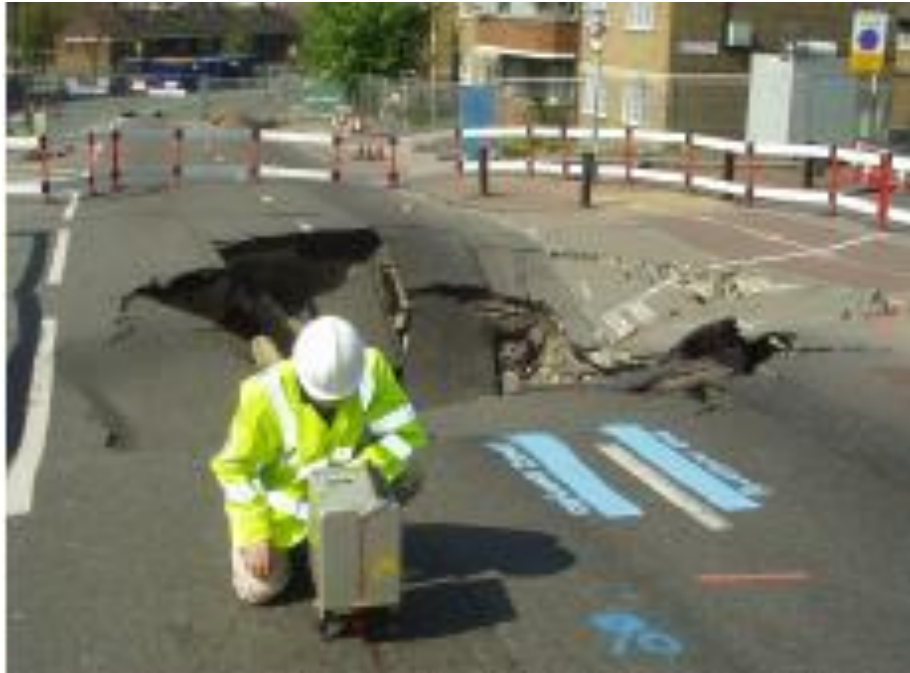
Φωτογραφία 2.1: Εφαρμογή μικροβαρυτομετρίας για τη χαρτογράφηση εγκαταλελειμμένου υπόγειου μεταλλείου σε περιοχή της Αγγλίας (Styles et al., 2004).
