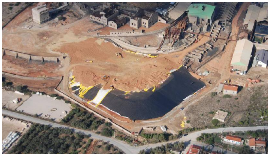
Φωτογραφία 1.9: Πανοραμικά άποψη της φάσης κατασκευής του Χ.Υ.Τ.Ρ.Ε. στο Λαύριο (Καλιαμπάκος, 2009).
