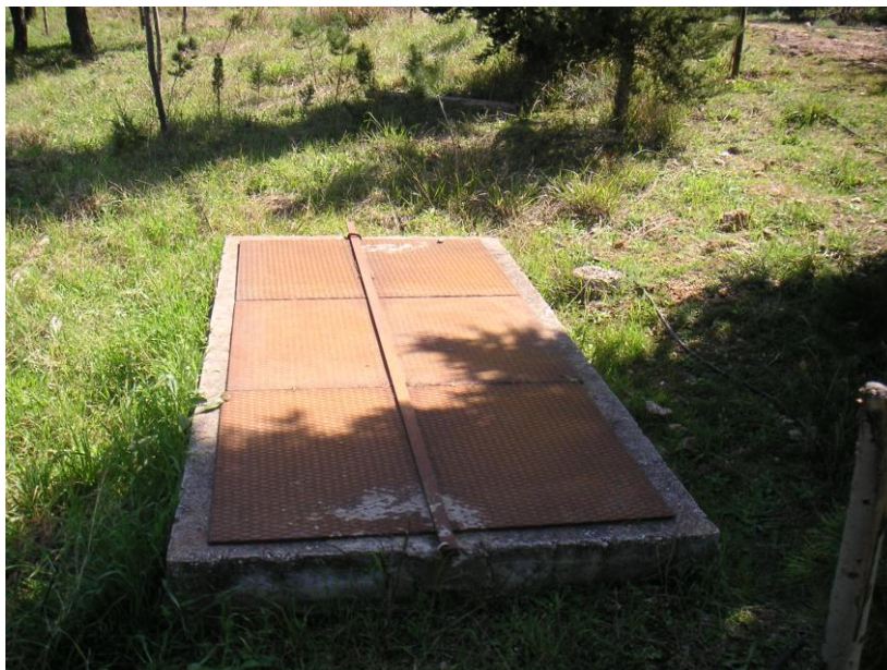
Φωτογραφία 3.1: Άποψη του φρεατίου επίσκεψης του αγωγού.
