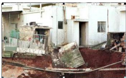
Φωτογραφία 1.5 : Προβλήματα που δημιουργήθηκαν από την ύπαρξη υπόγειων κενών κατά τη κατασκευή του μετρό στην Αθήνα.
