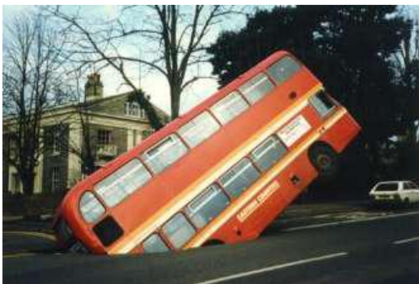
Φωτογραφία 4.1: Παράδειγμα κατάρρευσης εγκαταλελειμμένου υπόγειου μεταλλείου στην περιοχή Earham Norwich στην Αγγλία (Styles et al., 2004).
