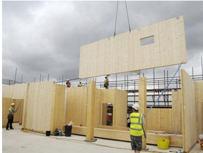
Εικόνα 3-1 Κατασκευή κτιρίου κατοικίας από πάνελ CLT [28]
