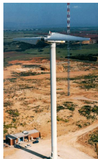
Εικόνα 1-27: Ανεμογεννήτρια Gamma 60 στο νησί της Σαρδηνίας (1992) (ρότορας διαμ. 60m, ισχύς 1.5MW) [1-6]
