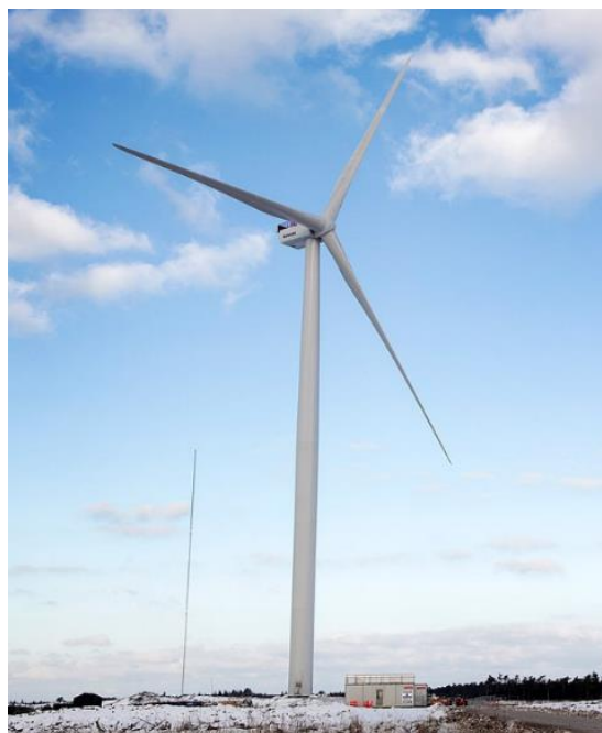
Εικόνα 1-29: Δανική ανεμογεννήτρια Vestas V164. Η μεγαλύτερη παγκοσμίως. (2014) (ρότορας διαμ. 160m, ισχύς 8MW)
