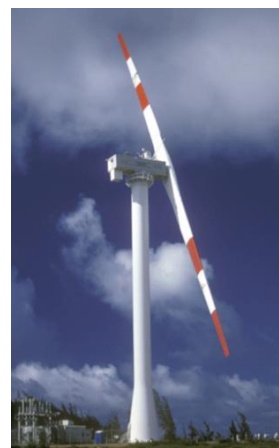
Εικόνα 1-20: MOD-5 (ρότορας διαμ. 97.5m, ισχύς 3.2MW) (1977) [1-6]
