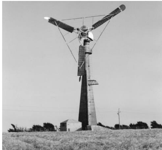
Εικόνα 1-14: Πειραματική ανεμογεννήτρια στο Gedser της Δανίας (ρότορας διαμ. 24m, ισχύς 200kW) (1957) [1-4]
