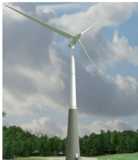
Εικόνα 1-36: Ανεμογεννήτρια με υβριδικό πυλώνα, από σκυρόδεμα στη βάση και χάλυβα στην κορυφή
