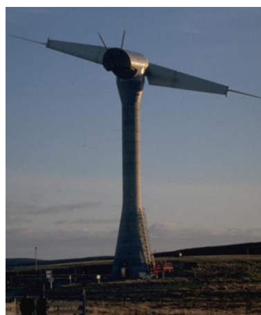
Εικόνα 1-25: Ανεμογεννήτρια LS-1 από τη Βρετανική εταιρεία WEG (1985) (ρότορας διαμ. 60m, ισχύς 3MW) [1-6]
