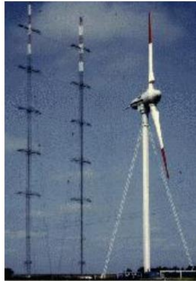
Εικόνα 1-22: Ανεμογεννήτρια του Γερμανού Growian (1983) (ρότορας διαμ. 100m, ισχύς 3MW) [1-5]
