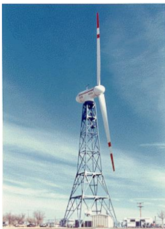
Εικόνα 1-17: MOD-0 (ρότορας διαμ. 38.1m, ισχύς 200kW) (1977) [[1-6]
