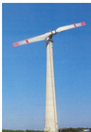
Εικόνα 1-24: Ανεμογεννήτρια WTS-75 στη Σουηδία (1982) (ρότορας διαμ. 75m, ισχύς 2MW) [1-6]
