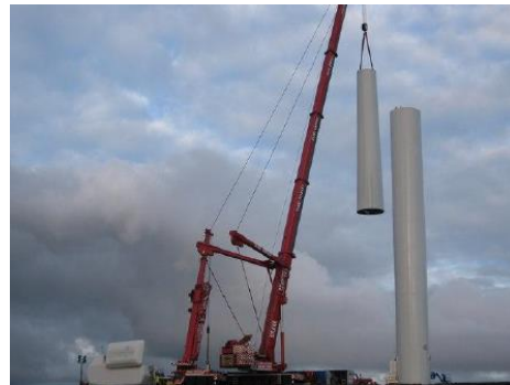
Εικόνα 1-42: Ανέγερση επιμέρους τμημάτων στο εργοτάξιο για σχηματισμό του πυλώνα [1-15]
