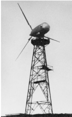
Εικόνα 1-13: Ανεμογεννήτρια των John Brown Company (1956) στα νησιά Orkney (ρότορας διαμ. 15m, ισχύς 100kW) [1-4]
