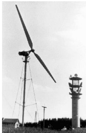
Εικόνα 1-16: Ανεμογεννήτρια του Γερμανού Hutter με πτερύγια υλικού υαλοβάμβακα και πλαστικού [1-5]
