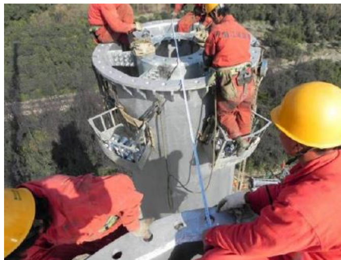
Εικόνα 2-9: Τοποθέτηση μετωπικών πλακών με κοχλίωση στο εργοτάξιο σε πυλώνα τηλεπικοινωνιών [2-4]
