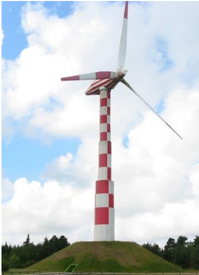
Εικόνα 1-21: Ανεμογεννήτρια από το σχολείο Tvind (1978) (ρότορας διαμ. 54m, ισχύς 2MW)
