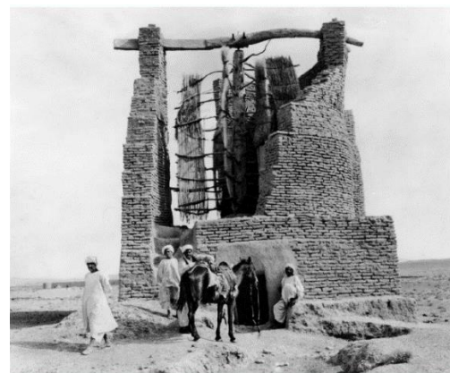
Εικόνα 1-2: Ανεμόμυλος στο Αφγανιστάν για άλεση σιτηρών [1-4]
