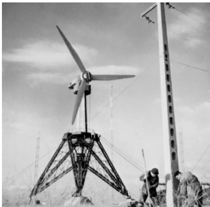
Εικόνα 1-15: Πειραματική ανεμογεννήτρια του Γάλλου μηχανικού Romani (1963) (ρότορας διαμ. 30,1m, ισχύς 800kW) [1-4]
