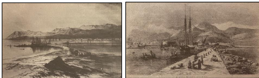
Εικόνες 59-60. Το εξωτερικό λιμάνι της πόλης και οι κατοικίες του παραλιακού μετώπου πριν και μετά την κατασκευή του κρηπιδώματος (λιθογραφία και σχέδιο E. Lear 1860, χαλκογραφία 1864).
