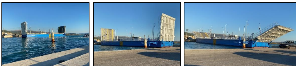
Εικόνες 40-42. Πλωτή γέφυρα Λευκάδας. Πηγή: Προσωπικό αρχείο.
