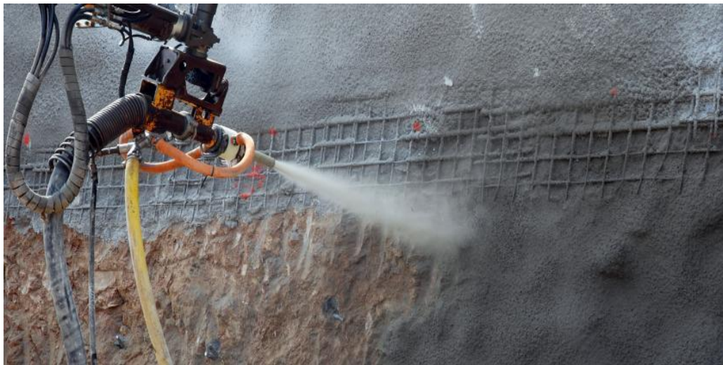
Εικόνα 2.7: Τοποθέτηση 1 ης στρώσης shotcrete με 1 πλέγμα T188
