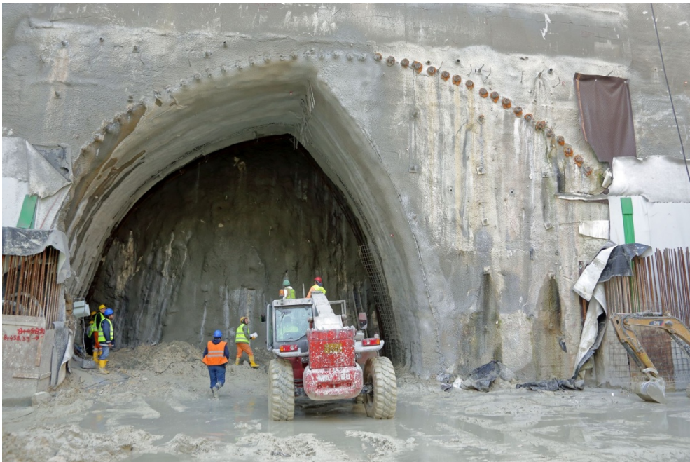
Εικόνα 2.9: Διάνοιξη της ημιδιατομής. A1 και τοποθέτηση της προσωρινής υποστήριξης [1]
