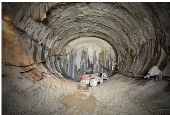
Εικόνα 2.11: Ολοκλήρωση Διάνοιξης Β φάσης.[1]
