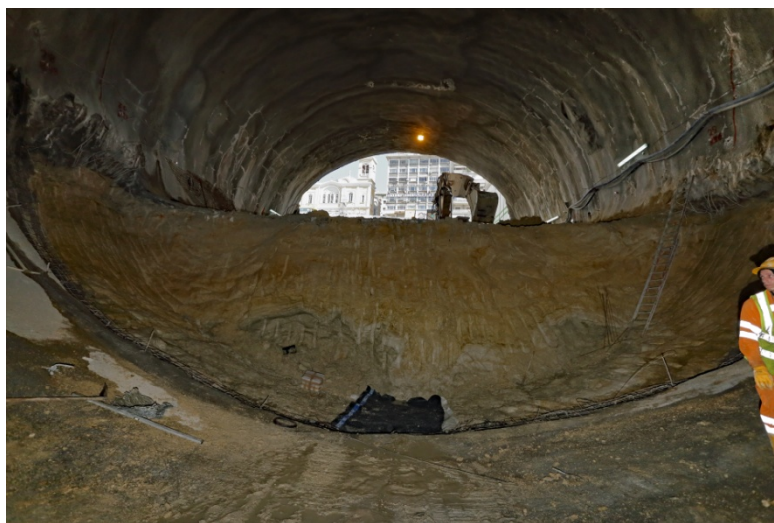
Εικόνα 2.10: Εκσκαφή βαθμίδας – Β φάση [1]
