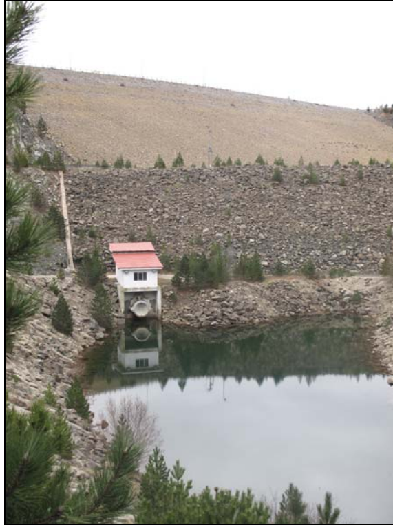
Εικόνα 8: Η έξοδος της σήραγγας εκκενωτή πυθμένα με τη βαλβίδα διασποράς στο πόδι του πρσανούς του κύριου φράγματος
