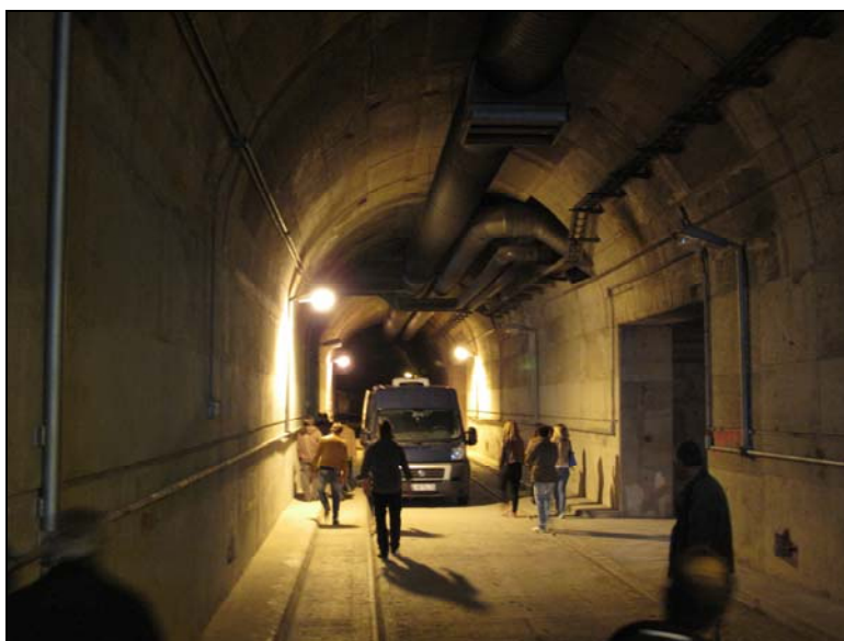
Εικόνα 13: Το εσωτερικό της σήραγγας προσπέλασης του σταθμού παραγωγής ενέργειας
