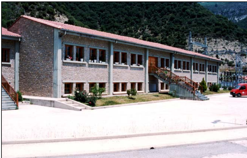
Εικόνα 20: Το κτίριο ελέγχου και λειτουργίας (Πηγή: Δ/ση ΥΗΣ Πηγών Αώου)
