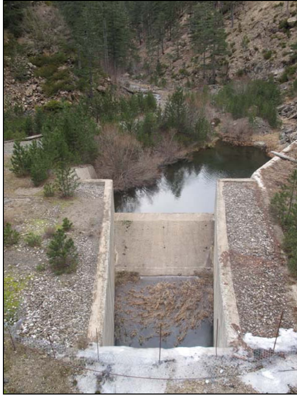
Εικόνα 7: Η έξοδος της σήραγγας εκτροπής και εκχειλιστή και η παλιά κοίτη του Αώου
