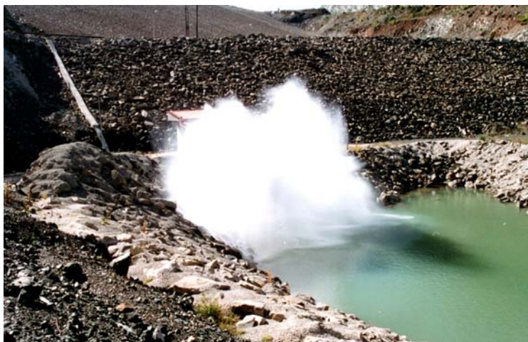
Εικόνα 9: Η βαλβίδα διασποράς σε λειτουργία (Πηγή: Δ/νση ΥΗΣ Πηγών Αώου)
