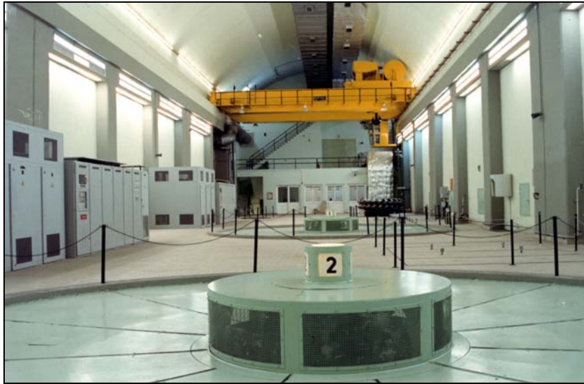
Εικόνα 15: Άποψη του επάνω επιπέδου του υπόγειου σταθμού παραγωγής
