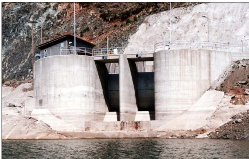
Εικόνα 6: Τα θυροφράγματα του εκχειλιστή όπως φαίνονται μέσα από την λίμνη (Πηγή: Δ/ση ΥΗΣ Πηγών Αώου)
