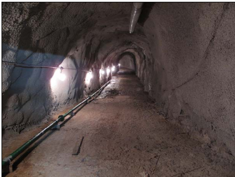
Εικόνα 18: Το εσωτερικό της σήραγγας φυγής
