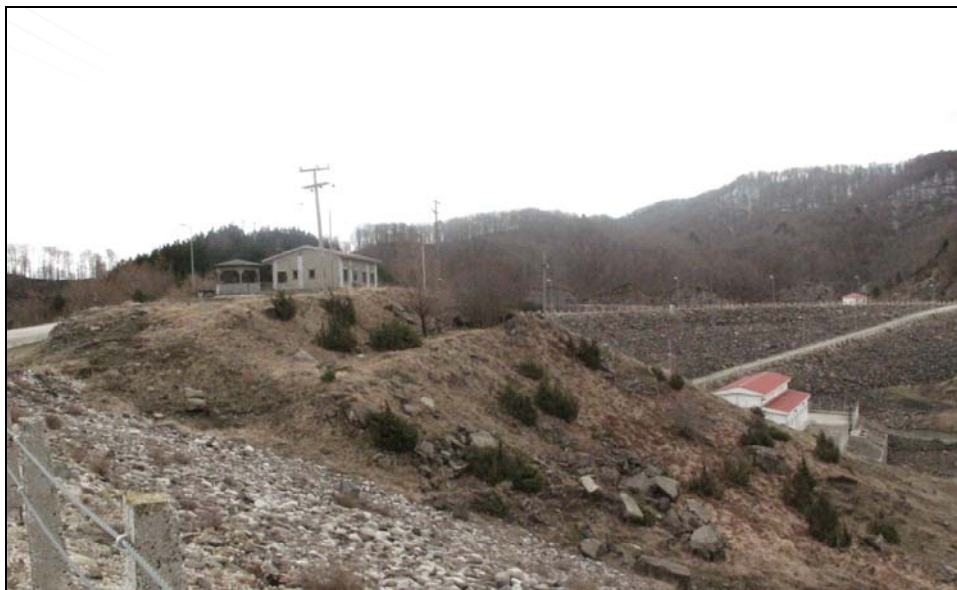
Εικόνα 12: Το καταφύγιο Πολιτσών (αριστερά) και το κτίριο του αντλιοστασίου (κάτω δεξιά)
