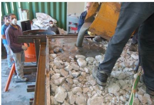
Εικόνα 2.4 : Έγχυση ΑΣΚ σε καλούπι προ-πληρωμένο με αδρανή (Khayat and Schutter, 2014)
