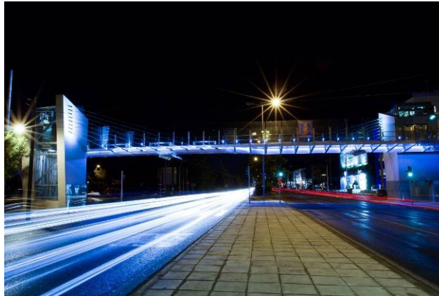
Εικόνα 2.3: Πεζογέφυρα επί της Λ. Κηφισίας (Lafarge)
