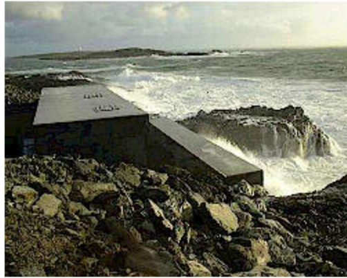
Εικόνα 2.21: Εγκατάσταση Limpet OWC στο νησί Islay [41]
