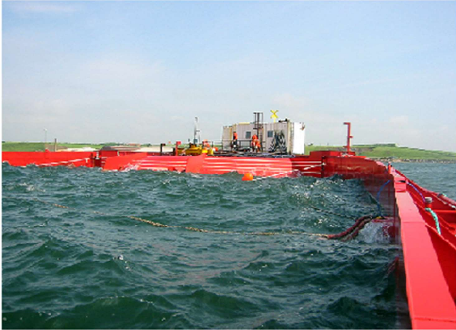
Εικόνα 2.15 Υπεράκτια συσκευή υπερχειλίσσης για την ανάκτηση κυματικής ενέργειας. Wave Dragon [41]
