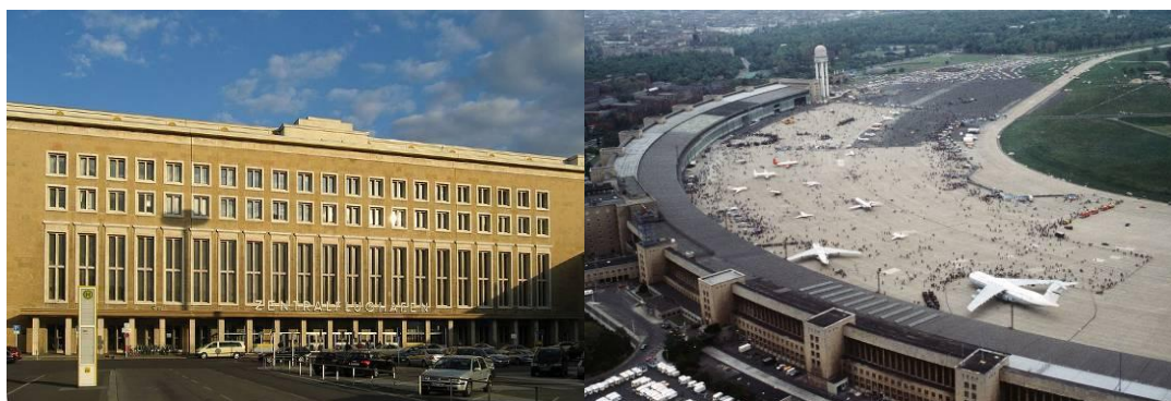
Εικόνα 3.4. Το αεροδρόμιο Tempelhof κατά τη περίοδο λειτουργίας του
