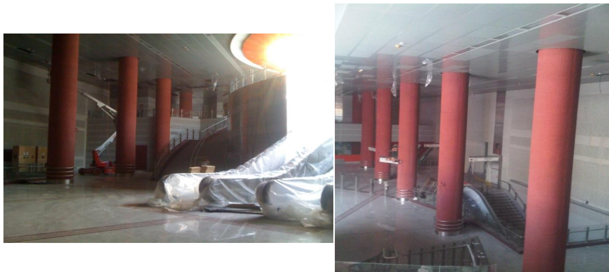
Σχήμα 2-41: Γενική άποψη εσωτερικά του σταθμού "ΠΕΡΙΣΤΕΡΙ".
