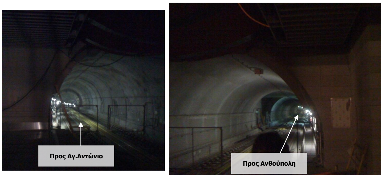
Σχήμα 2-42: Υπόγειο άνοιγμα διευρυμένης διατομής του σταθμού "ΠΕΡΙΣΤΕΡΙ".
