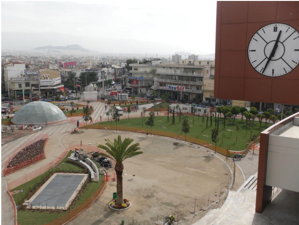
Σχήμα 1-1: Ευρύτερη άποψη εξωτερικά του σταθμού «Περιστερί».
