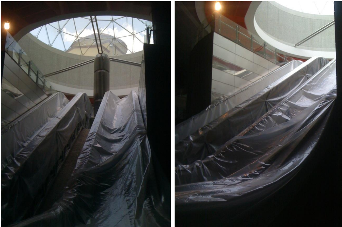
Σχήμα 2-40: Σκάλες εισόδου – εξόδου σταθμού "ΠΕΡΙΣΤΕΡΙ".
