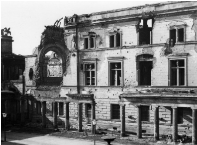
88. Η βορειοδυτική γωνία του κτηρίου κατέρρευσε μετά τον βομβαρδισμό
