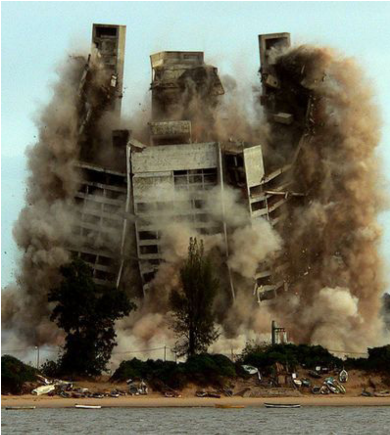
Εικ 3.4: Κατεδάφιση κτιρίου με χρήση εκρηκτικών
