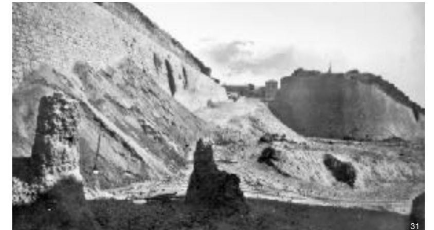
3. Αποψη νότιου προμαχάνα (1900)
