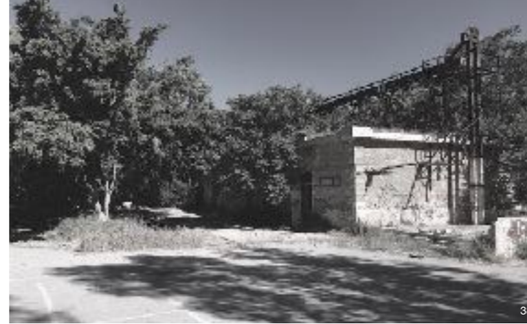
2. Άποψη από κάτω στάθμη
