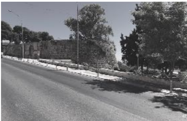
6. Άποψη άνω επιπέδου οδού Ικάρων
