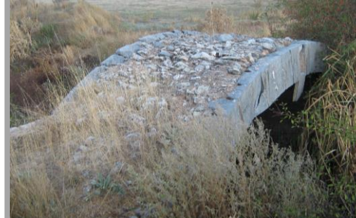
εικ1. πέτρινο γεφύρι στις «Καταβόθρες» 2
