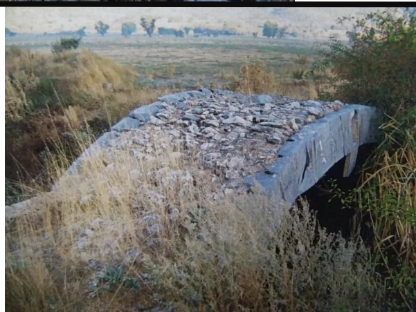
ΓΕΦΥΡΙ ΘΕΣΗ "ΚΑΤΑΒΟΘΕΡΕΣ" ΑΡΧΕΣ 19ου
