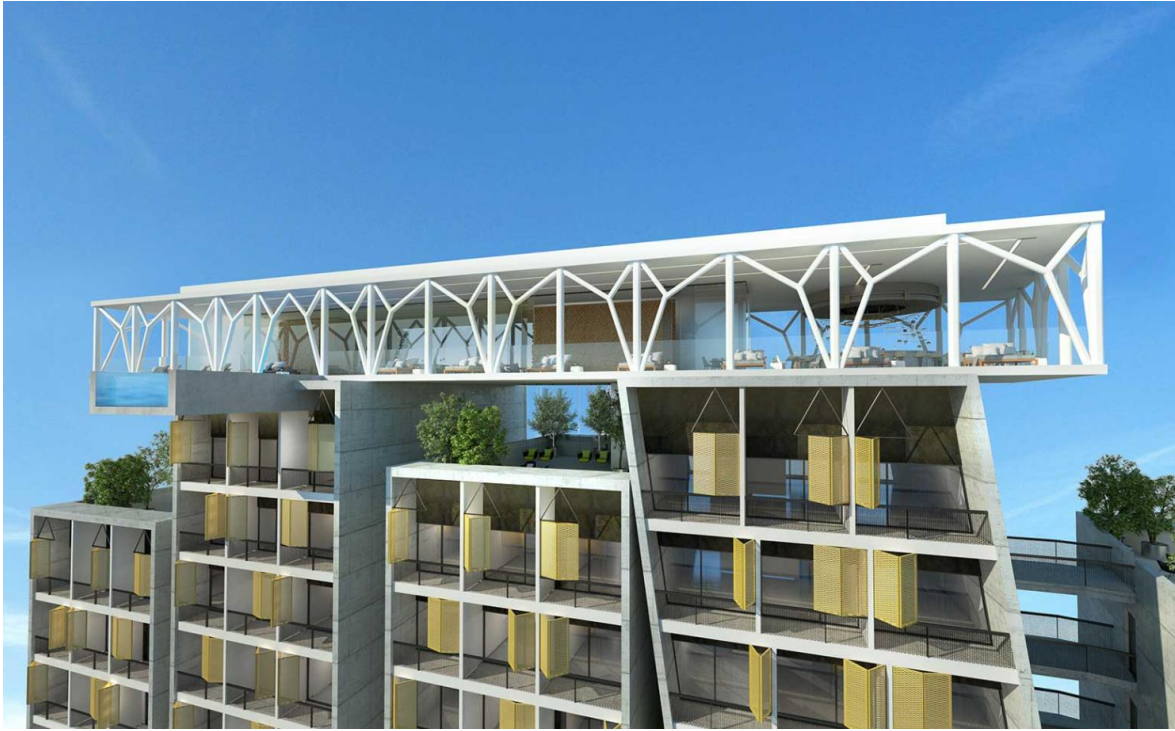
Εικόνα 4.14 Ο σεισμικά μονωμένος όροφος του κτιρίου εστιών SIX του Πανεπιστημίου Λευκωσίας.
