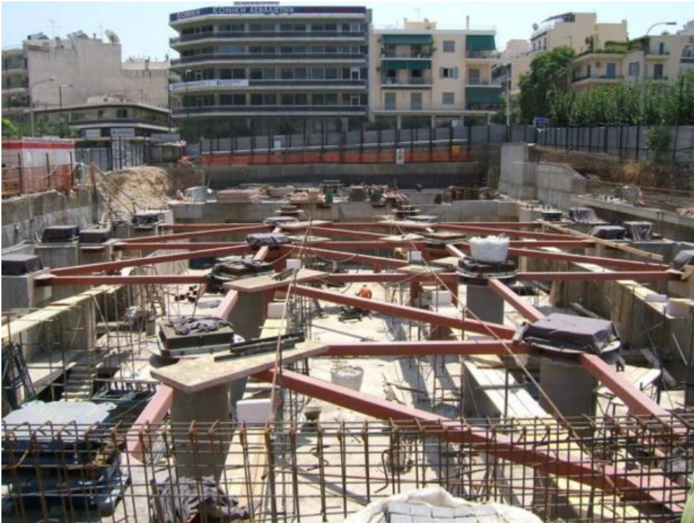
Εικόνα 4.5 Η στάθμη της σεισμικής μόνωσης στην Ωνάσειο Στέγη Γραμμάτων και Τεχνών στη φάση ανέγερσης. Διακρίνεται το δικτύωμα που προσδίδει τη διαφραγματική λειτουργία στο επίπεδο κάτω από την μόνωση (46 εφέδρανα τριβής FPS).
