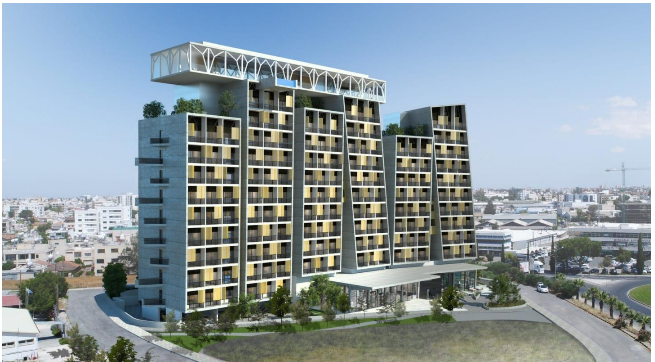
Εικόνα 4.13 Το κτίριο που στεγάζονται οι εστίες SIX του Πανεπιστημίου Λευκωσίας.
