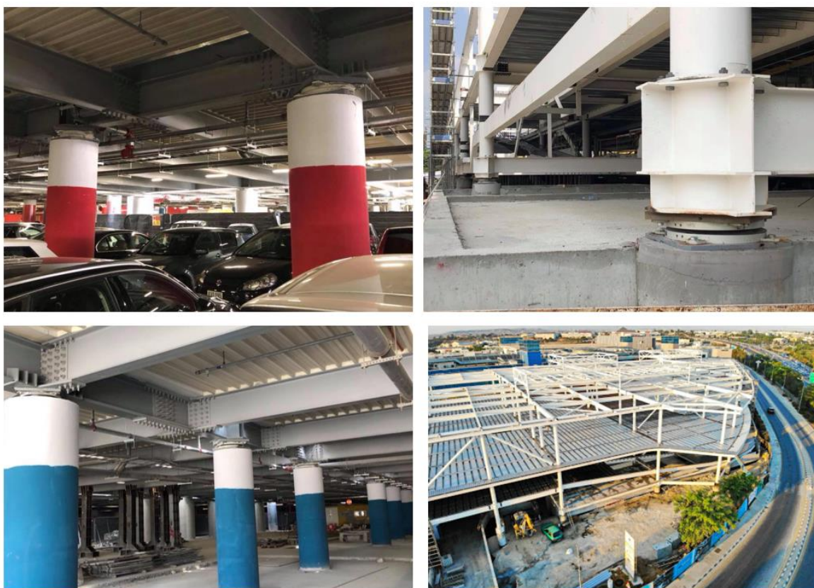
Εικόνα 4.11 Φωτογραφίες από το σύστημα σεισμικής μόνωσης στο Mall of Cyprus.
