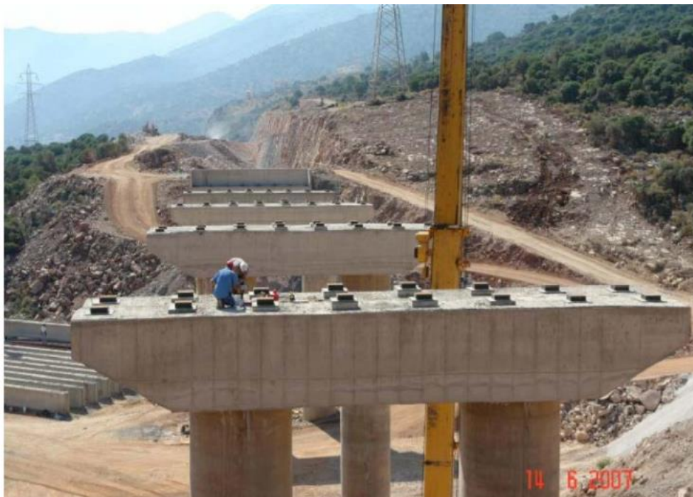
Εικόνα 4.10 Εγκατάσταση εφεδράνων στα βάθρα οδικής γέφυρας στο τμήμα Σταλίδα-Μάλια, Κρήτη.
