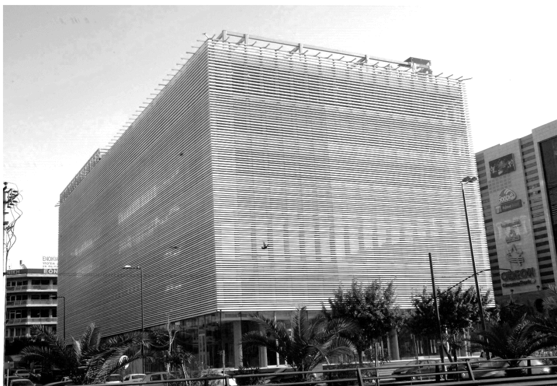
Εικόνα 4.8 Εξωτερική άποψη της Ωνάσειου Στέγης Γραμμάτων και Τεχνών. Διακρίνουμε ότι το κτίριο είναι δύσκαμπτο (χαμηλού έως μεσαίου ύψους), επομένως είναι αποτελεσματική η τοποθέτηση σεισμικής μόνωσης.
