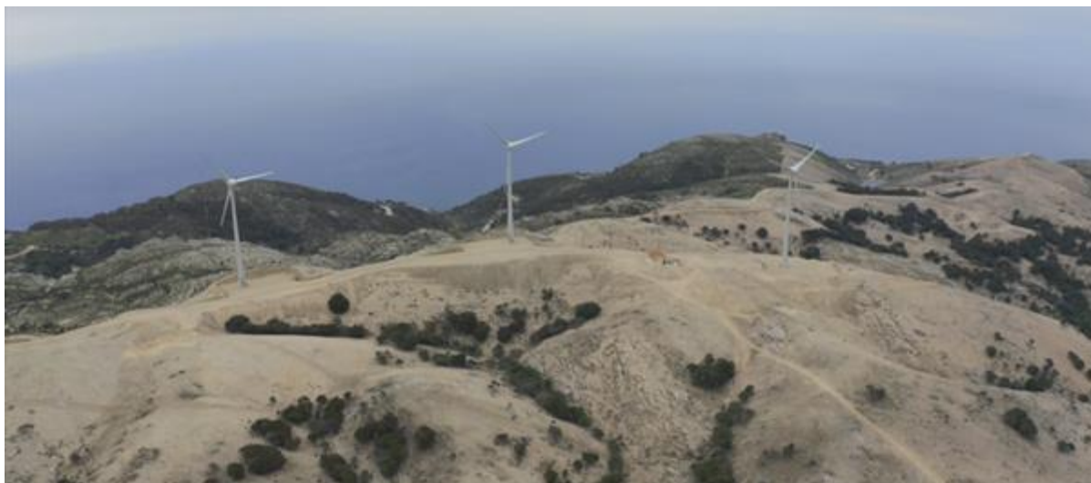
Εικόνα 1-4 Αιολικό Πάρκο Στραβοκουντούρας με τρεις (3) Α/Γ των 900 kW η καθεμία, [9]
