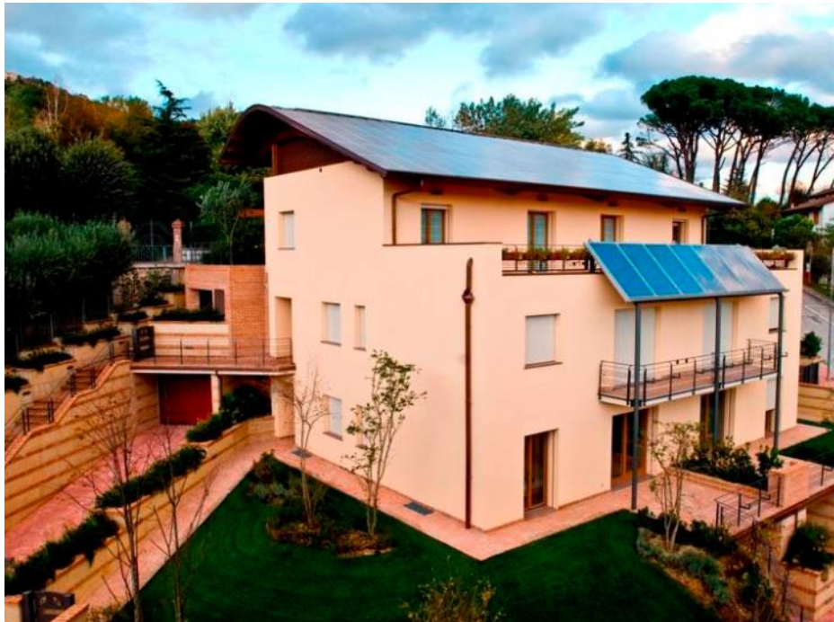
Εικόνα 3.5: Κτίριο ΜΚΕ στην Ιταλία[16]
