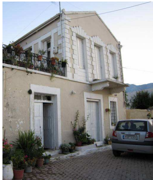
Εικόνα 56 Αναπαλαιωμένο κτίριο της οδού Μάχης Κρήτης στην πλατεία της Παναγίτσας στην τοπική κοινότητα Σίβας.
