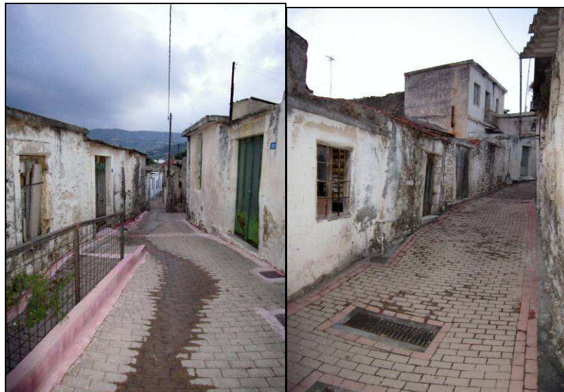
Εικόνα 33 Εγκαταλελειμμένα κτίρια της οδού Χαλκιδιού και της οδού Γ. Πρικάκη στην τοπική κοινότητα Βενεράτου.
