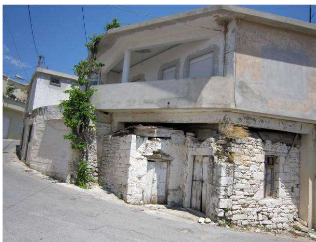
Εικόνα 23 Κτίριο της οδού Ελευθ. Βενιζέλου στην τοπική κοινότητα Αυγενικής
