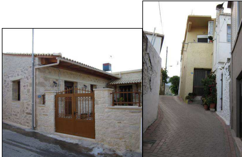
Εικόνα 21 Αριστερά παραδοσιακό αναπαλαιωμένο κτίριο και δεξιά κτίρια νεότερης αρχιτεκτονικής στην τοπική κοινότητα Αυγενικής
