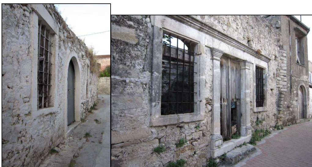
Εικόνα 54 Εγκαταλελειμμένα κτίρια της οδού Γ.Φραγκιαδάκη (αριστερά) και της οδού Μάχης Κρήτης (δεξιά) στην τοπική κοινότητα Σίβας.
