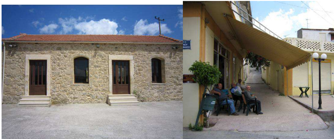
Εικόνα 49 Αριστερά πρώην σχολείο- κτίριο πολιτιστικού συλλόγου. Δεξιά το καφενείο στα Κεράσια στην τοπική κοινότητα Κερασίων.
