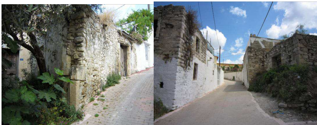
Εικόνα 44 Αναπαλαιωμένα κτίρια στην οδό Ζωοδόχου Πηγής στην τοπική κοινότητα Κερασιών.
