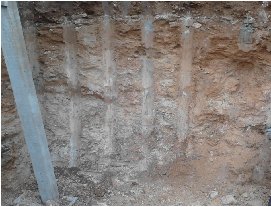
Φωτογραφία 7.1: Χαρακτηριστική τομή τεταρτογενών σχηματισμών θεμελίων πολυκατοικίας στην Παιανία
