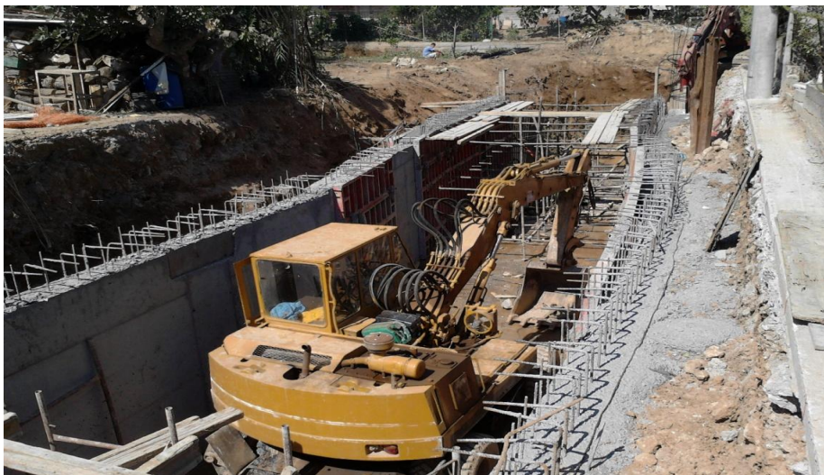
Φωτογραφία 8.2: Τμήμα αγωγού στην οδό Ιωάννη Αθανασίου
