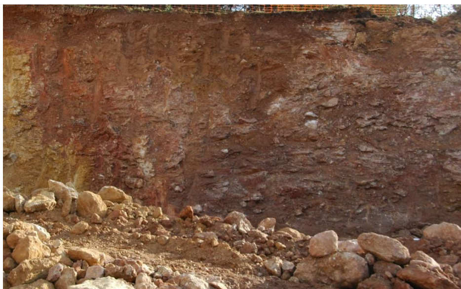
Φωτογραφία 6.9: Δήμος Γλυκών Νερών, περιοχή εκσκαφής Ιατρικού Πάρκου Αθηνών. Πρόσοψη του πρανούς όπου επικρατεί ο ψαμμίτης
