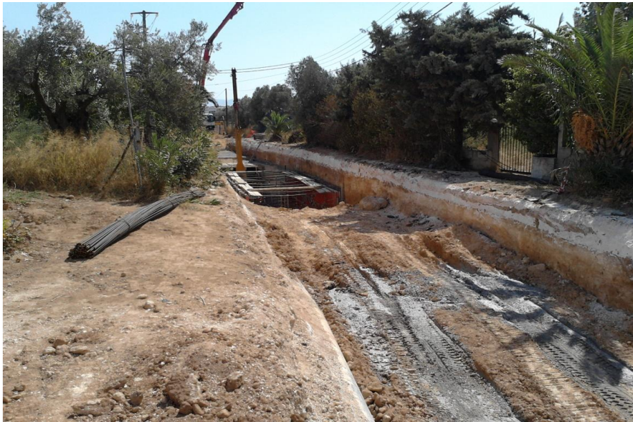
Φωτογραφία 8.1: Τμήμα αγωγού στην οδό Αγίου Λουκά
