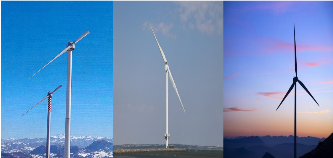
Σχήμα 2.6: Τυπική ανεμογεννήτρια οριζόντιου άξονα με ένα, δύο και τρία πτερύγια (Πηγές: www.wind-energy-the-facts.org , www.wind-turbine-models.com , www.terna-energy.com ) [16], [17], [18]
