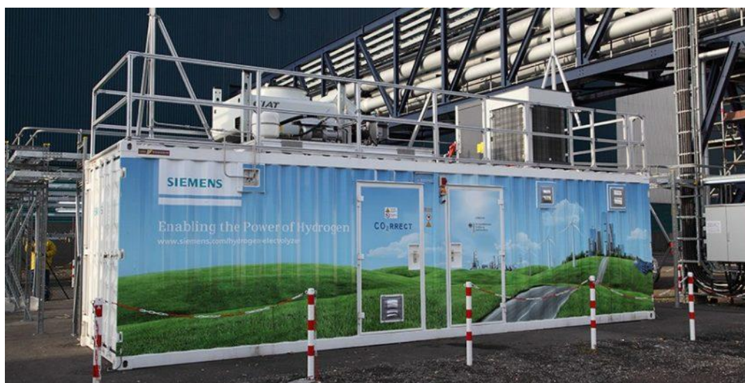
Εικόνα 3.1.1 PEM ηλεκτρολύτης 500 kW της εταιρείας Siemens [32]
