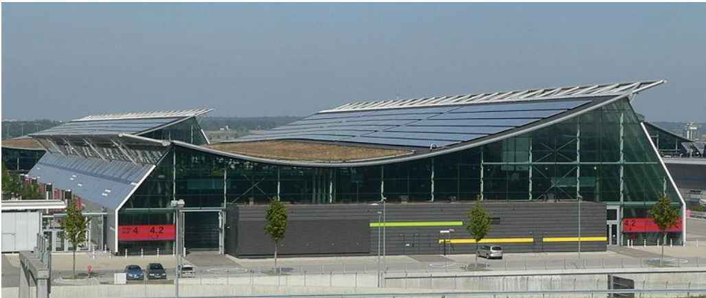
Εικόνα 1.1 Πρόσοψη Paul Horn Halle (Hall 10)
