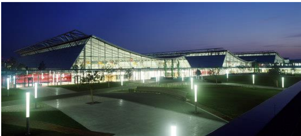
Εικόνα 1.2 Φωτογραφία: Νυχτερινή εικόνα Paul Horn Halle (Hall 10)
