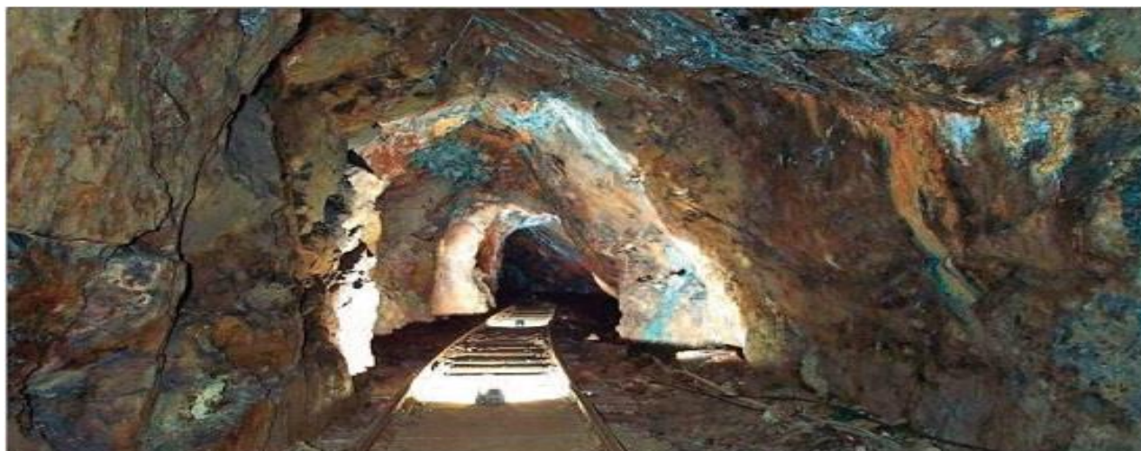
ΕΙΚΟΝΑ 2: Υπόγεια στοά του πρώην ορυχείου χαλκού στο Λιμογάρδι Λαμίας με γραμμές Decauville.
