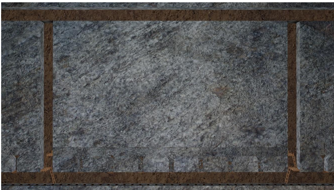
Εικόνα 5-39: Στιγμιότυπο 1 από τη διάνοιξη της υποστοάς.
