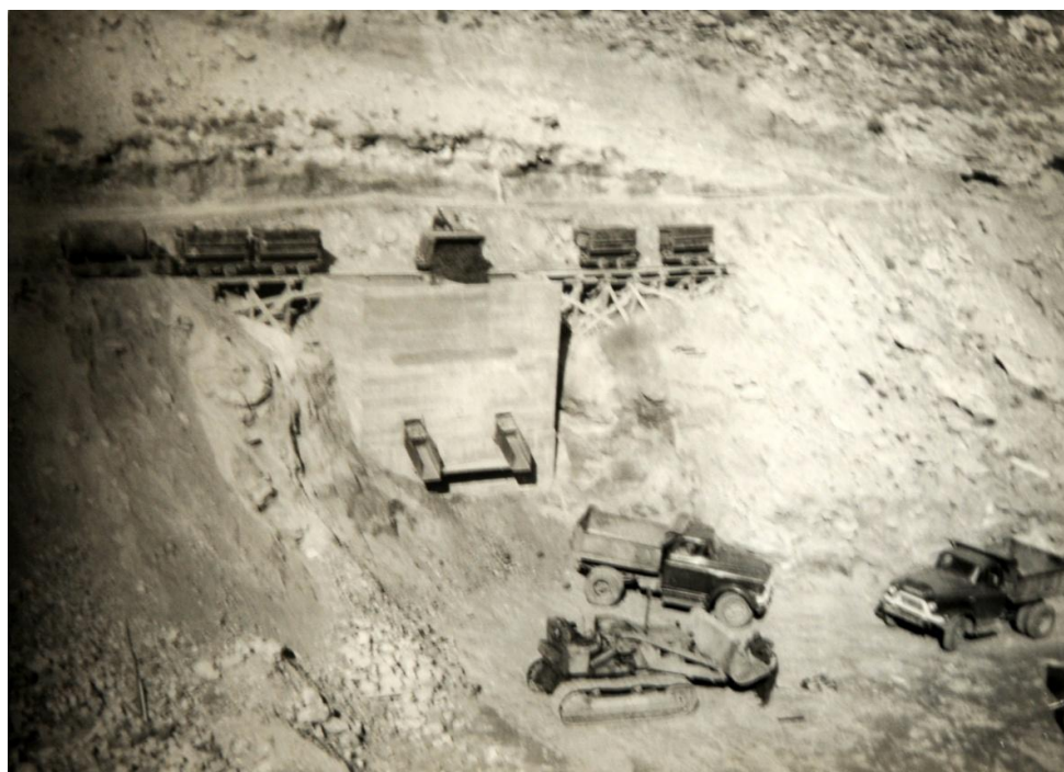
Εικόνα 4-22: Απόληψη σπασμένου μεταλλεύματος σε σιλό και συλλογή από φορτηγά. (Πηγή: Αρχείο φωτογραφιών Δήμητρας Λοΐζου-Βουλγαράκη)
