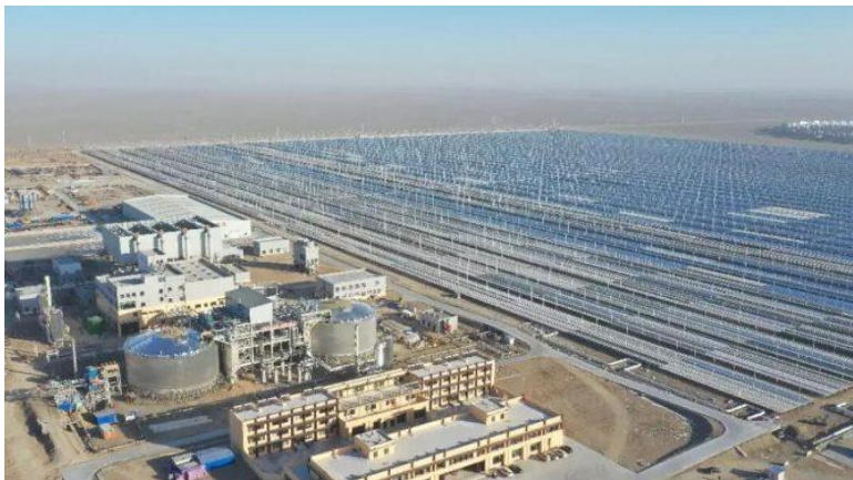
Εικόνα 2.8: Εγκατάσταση συλλεκτών Fresnel στην Κίνα [33].
