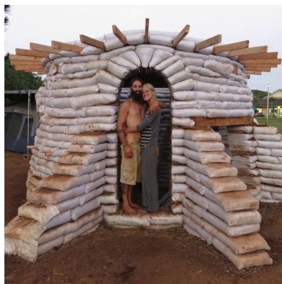
Εικόνα 41: Κτίριο κατασκευασμένο με την τεχνική των γαιόσακων
