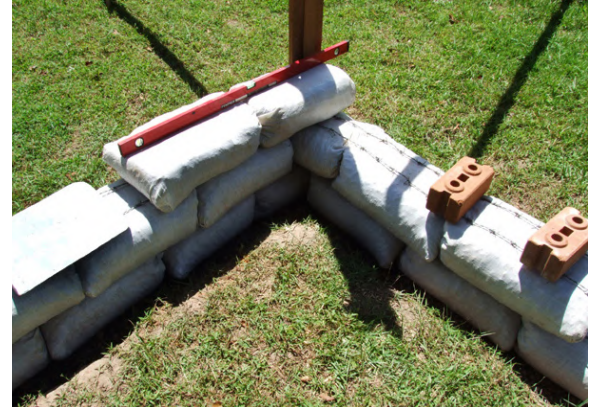
Εικόνα 36: Τοποθέτηση επόμενης σειράς σακών γεμάτο χώμα
