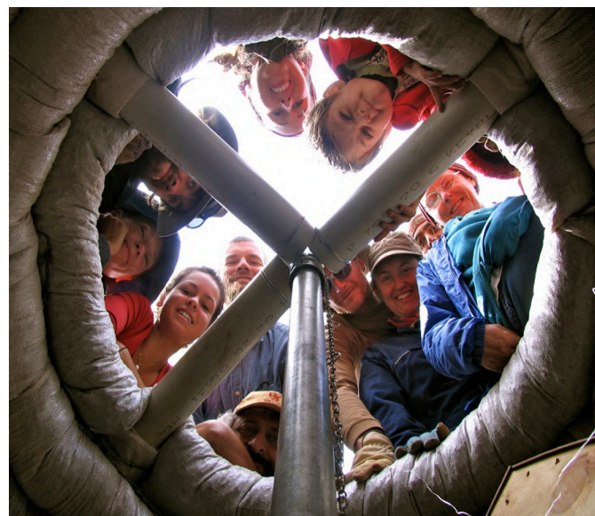
Εικόνα 25: Κατασκευή τρούλου από γαιόσακους
