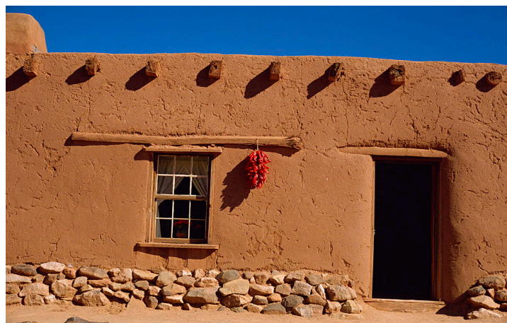
Εικόνα 49: Κτίριο κατασκευασμένο με πλιθιά
