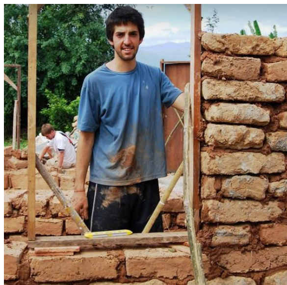
Εικόνα 28: κατασκευή τοίχου με πλιθιά
