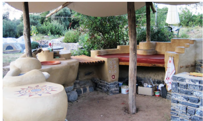
Εικόνα 29: γλυπτικές μορφές με την τεχνική του cob
