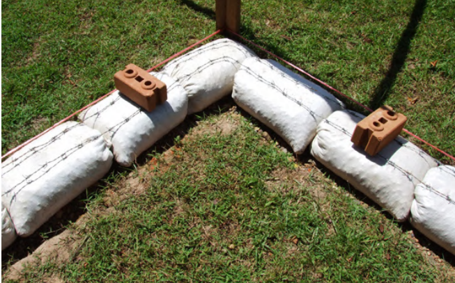
Εικόνα 35: Τοποθέτηση συρματοπλέγματος για αντοχή σε εφελκυσμό
