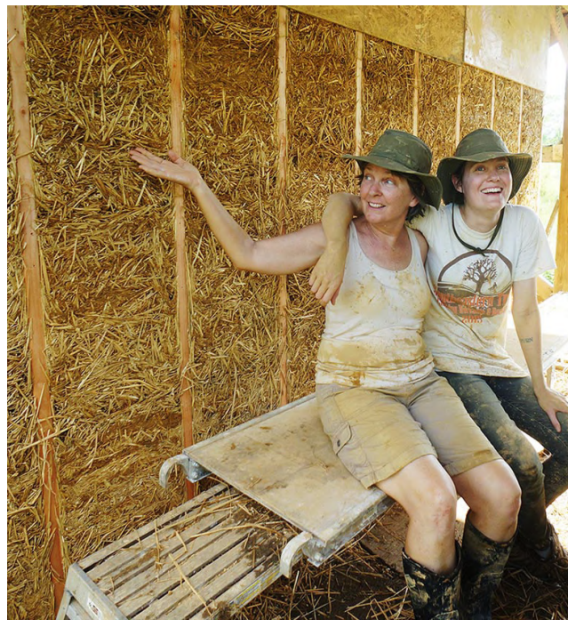
Εικόνα 32: κατασκευή τοίχου με αχυροπηλό
