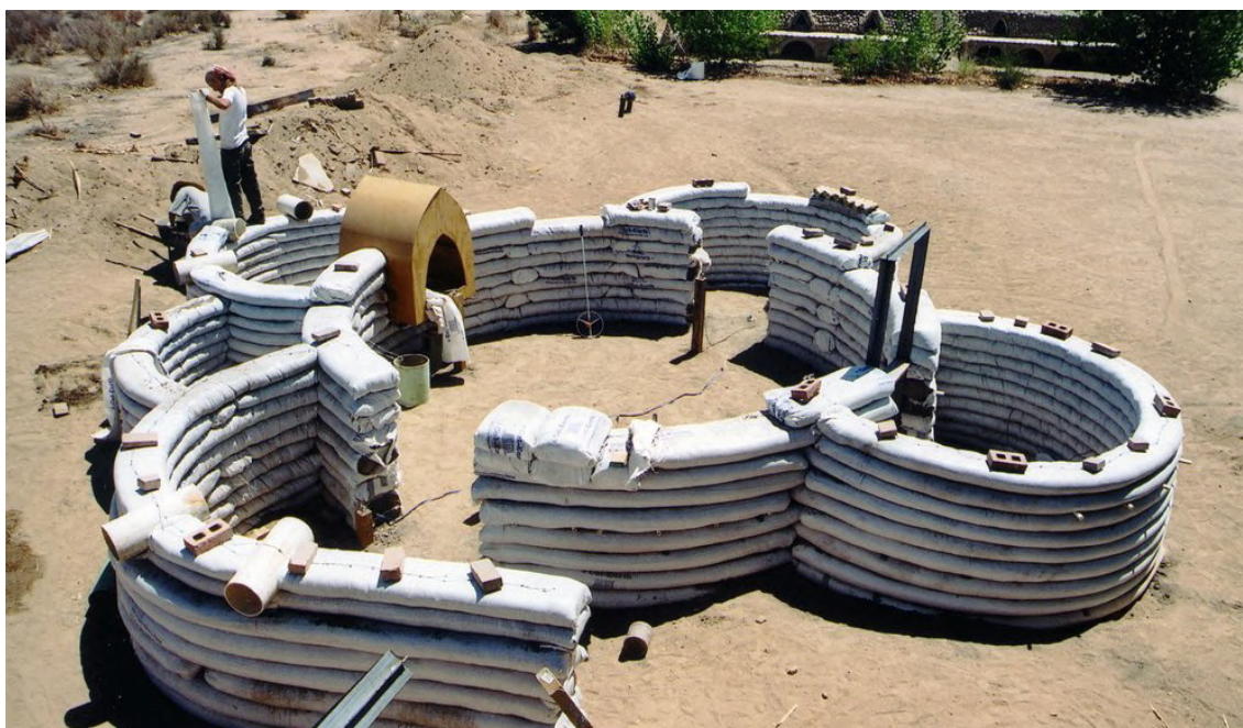
Εικόνα 26: κατασκευή κτιρίου με την τεχνική των γαιόσακων
