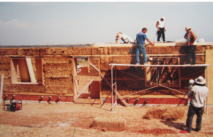
Εικόνα 20: Κατασκευή κτιρίου από αχυρόμπαλες στην οικοκοινότητα Σκάλα
