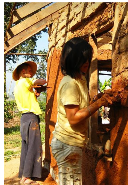
Εικόνα 18: Κατασκευή με πλιθιά
