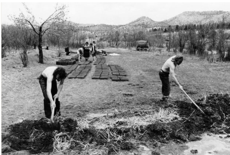
Εικόνα 27: τα πλιθιά σε σειρές, αποξηραίνονται στον ήλιο
