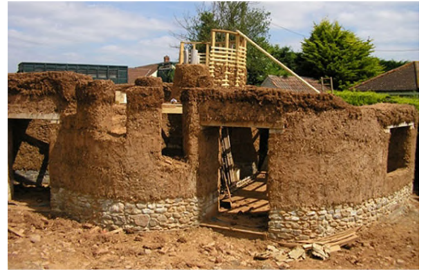
Εικόνα 47: Κτίριο απο cob με πετρόχτιστη βάση
