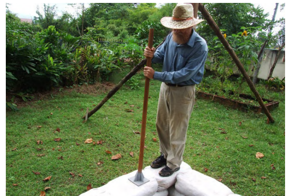
Εικόνα 37: Συμπίεση για καλύτερη πρόσφυση μεταξύ των δυο στρώσεων
