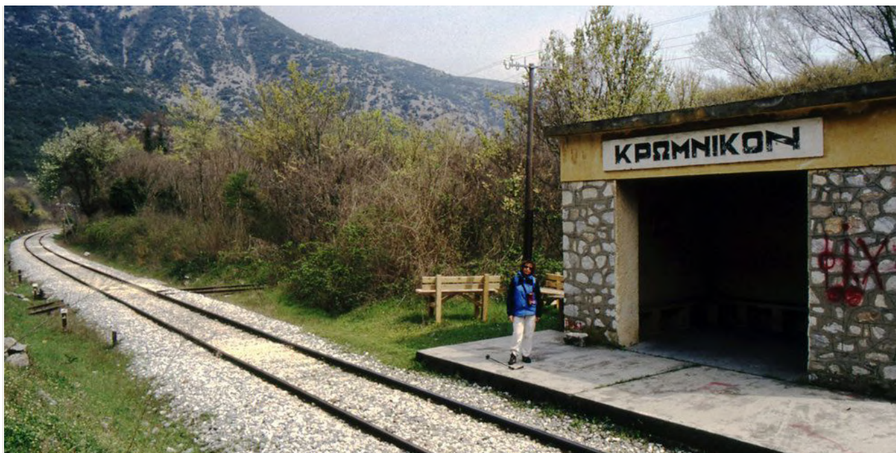
Εικόνα 80: σιδηροδρομικός σταθμός Κρωμνικόν
