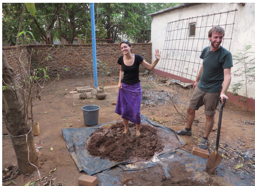
Εικόνα 50: Διαδικασία ανακατέματος των υλών του μείγματος adobe
