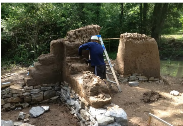
Εικόνα 43: Δόμηση με cob πάνω στην πετρόχτιστη βάση
