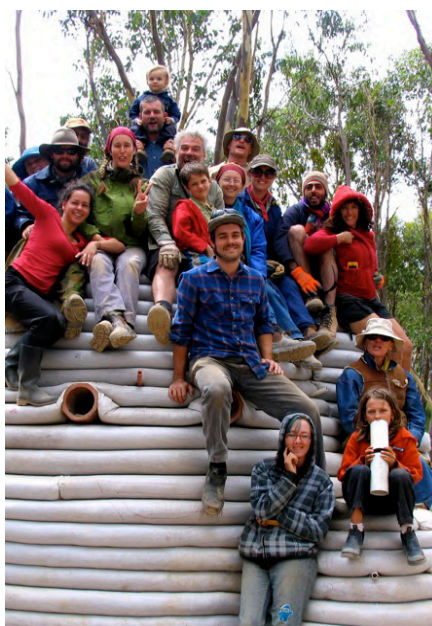
Εικόνα 17: Κατασκευή τρούλου με γαϊόσακους
