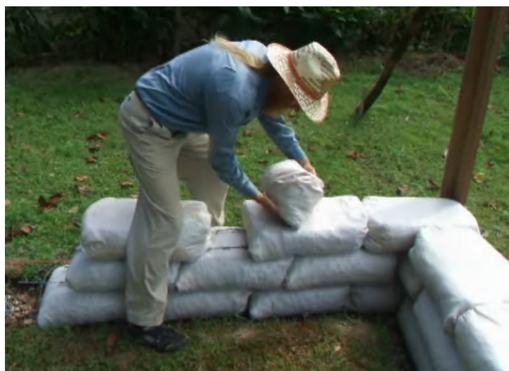
Εικόνα 38: Τοποθέτηση μικρότερου κομματιού γαιόσακου
