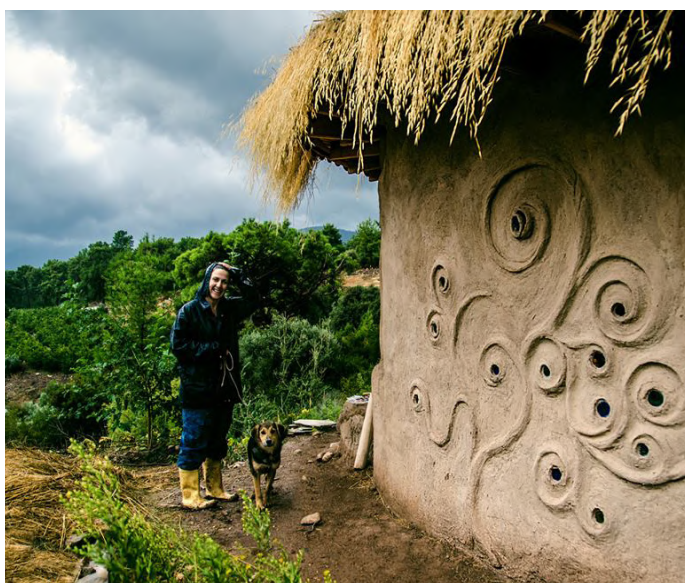
Εικόνα 40: Κτίριο από γαιόσακους με εξωτερικό σοβάτισμα από αργιλόχωμα
