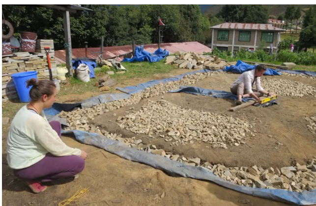
Εικόνα 42: τάφρος, η οποία γεμίζεται με χαλίκια
