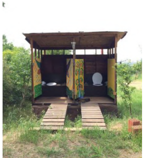
Εικόνα 52: (Αριστερά) εγκατάσταση βιοαερίου, (Δεξιά) τουαλέτες κομποστοποίησης
