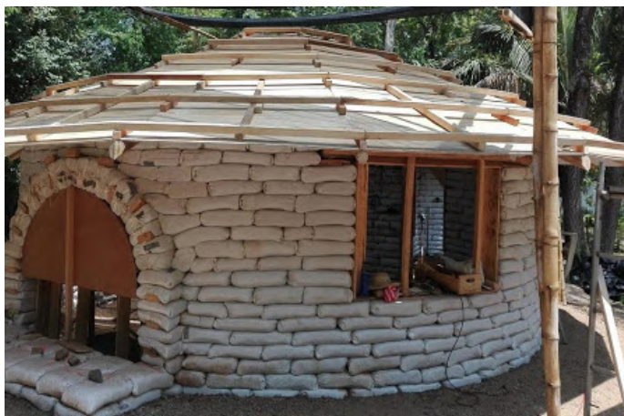
Εικόνα 39: Κτίριο κατασκευασμένο με την τεχνική των γαιόσακων
