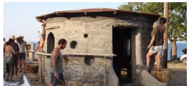
Εικόνα 48: Κτίριο κατασκευασμένο με την τεχνική του cob
