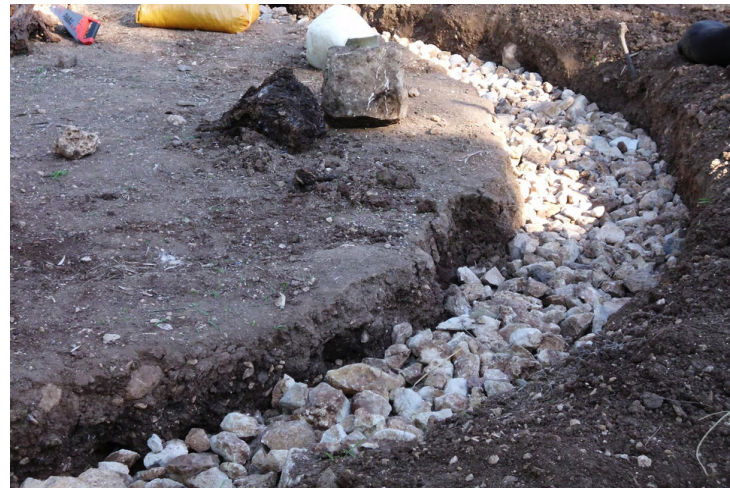
Εικόνα 33: τάφρος, βάθους μισού μέτρου (0,50μ)
