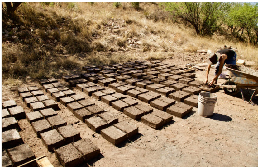
Εικόνα 51: Πλιθιά σε σειρές αποξηραίνονται στον ήλιο
