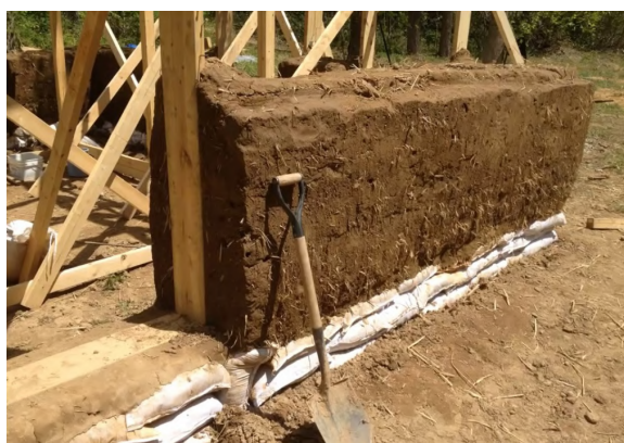
Εικόνα 45: Δόμηση με cob πάνω σε βάση από γαιόσακους
