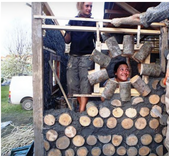
Εικόνα 30: κατασκευή τοίχου με καυσόξυλα
