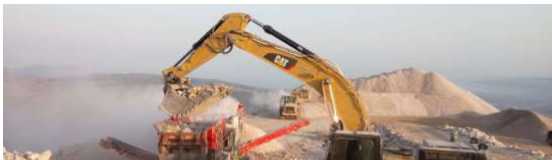
Εικόνα 3.2 Εργασίες κατά τη φάση κατασκευής του αιολικού πάρκου Πεταλάς συνολική δυναμικής 48MW στα όρια του Δήμου Αμφιλοχίας. Πηγή: ΕΛΕΜΚΑ
