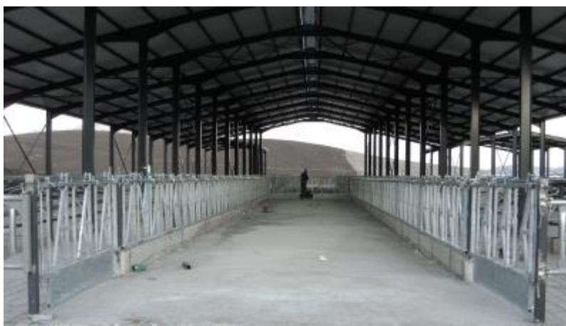
Εικ.6.1 : Φωτογραφία υποστέγου κατάλληλο για βουστάσιο στην χώρα μας.[23]
