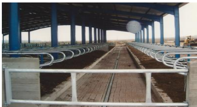
Εικ.10.4: Διάδρομος κυκλοφορίας στον οποίο διακρίνουμε τις ραβδώσεις και το αυλάκι για το συρματόσχοινο [22]
