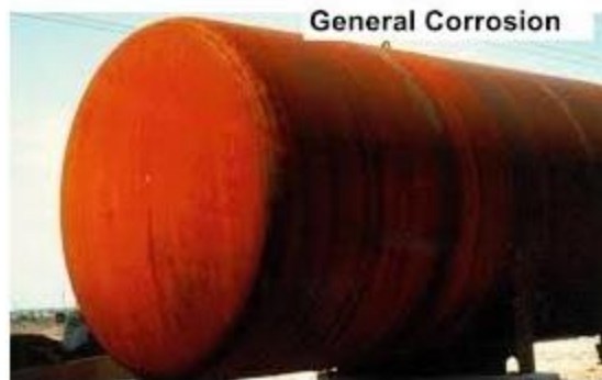
Εικόνα 2.2.1.1. Επιφάνεια μετάλλου που έχει υποστεί ομοιόμορφη διάβρωση [16]
