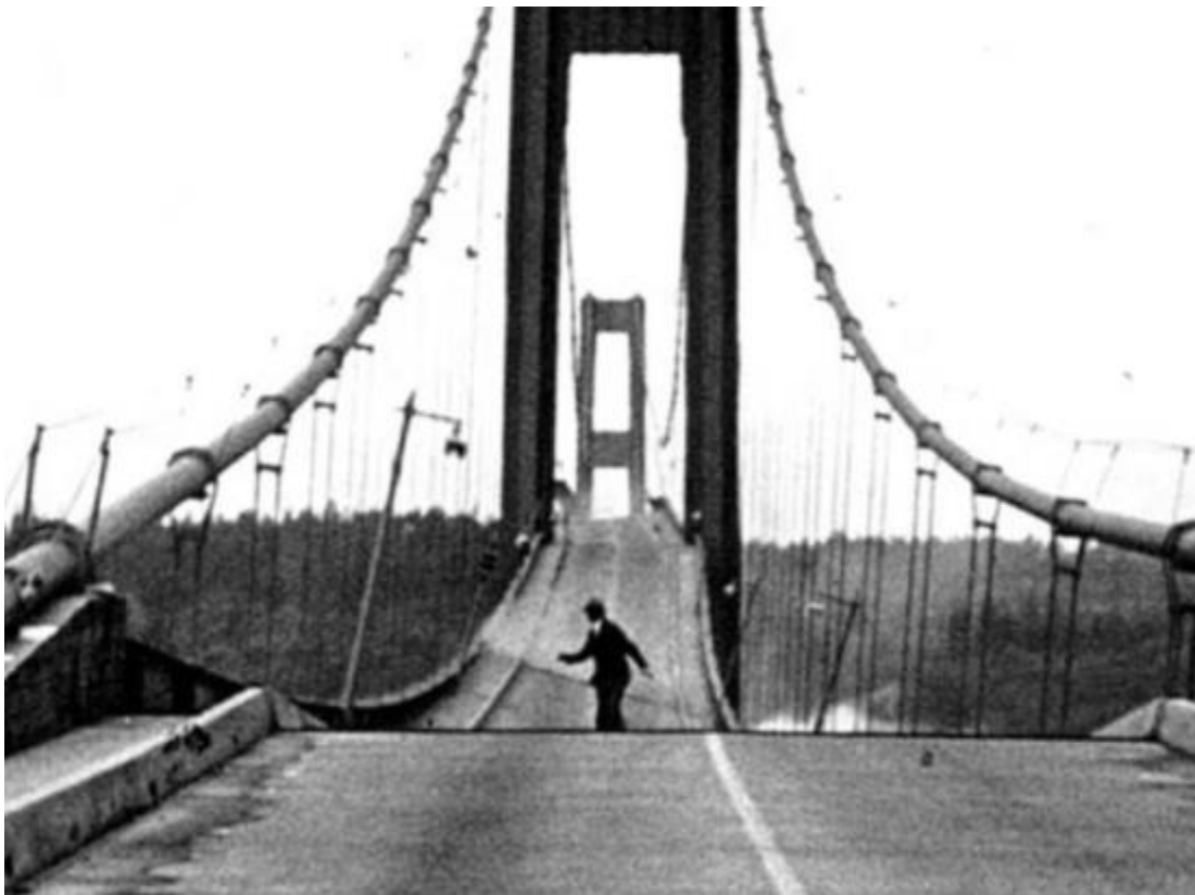
Εικόνα 41: Αστοχία λόγω συντονισμού της γέφυρας Τάκομα στις Η.Π.Α. το 1940.
