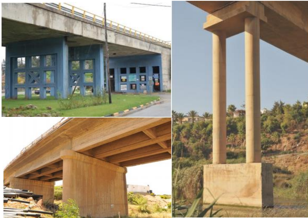
Σχήμα 10.1- Μορφές Μεσοβάθρων
