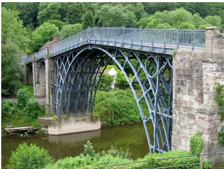
Σχήμα 1.3: Η πρώτη γέφυρα από χυτοσίδηρο Iron Bridge, Αγγλία (1779 μ.Χ.)
