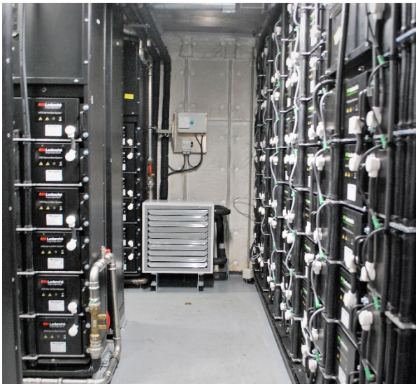
Εικόνα 5: Διάταξη μπαταριών στο πλοίο Ellen Ferry-boat.
