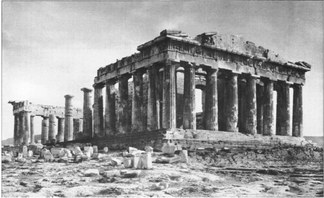
Εικόνα 86: Ο Παρθενώνας από ΒΔ μετά την αναστήλωση του 1844. Διακρίνονται οι πλήρως αναστηλωμένοι κίονες 9 και 11 και οι μερικώς αναστηλωμένοι 6, 7, 8 και 10. (Μελέτη Δομικής Αποκαταστάσεως της Βόρειας Όψης του Παρθενώνος, Κ.Ζάμπας, ΥΠΠΟ, ΕΣΜΑ, Αθήνα 2002, σ. 26)
