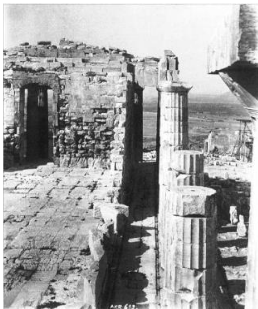
Εικόνα 102: Το βόρειο περὶ και οι αναστηλωμένοι κίονες περί το 1909. Στον τελευταίο σπόνδυλο του δεύτερου κίονα διακρίνονται δύο σύνδεσμοι Π. (Μελέτη Δομικής Αποκαταστάσεως της Βόρειας Όψης του Παρθενώνος, Κ.Ζάμπας, ΥΠΠΟ, ΕΣΜΑ, Αθήνα 2002, σ. 49)
