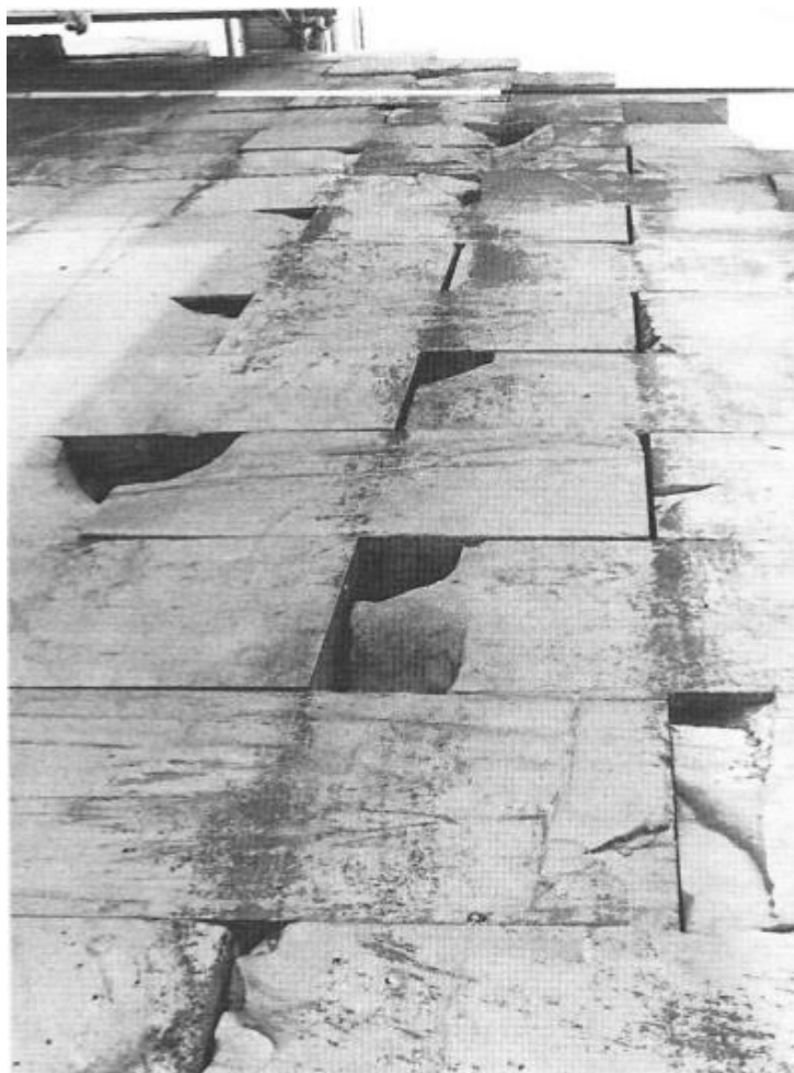
Εικόνα 64: Η εξωτερική επιφάνεια του νότιου τοίχου με τους διανοιγμένους αρμούς στη θέση συνάντησης με τον Δυτικό Θυραίο τοίχο (Μελέτη Αποκαταστάσεως του Παρθενώνος, Τόμος 3β, Δομική Μελέτη Αποκαταστάσεως Οπισθονάου, Κ. Ζάμπας, ΥΠΠΟ, ΕΣΜΑ, Αθήνα 1994, σ. 15)
