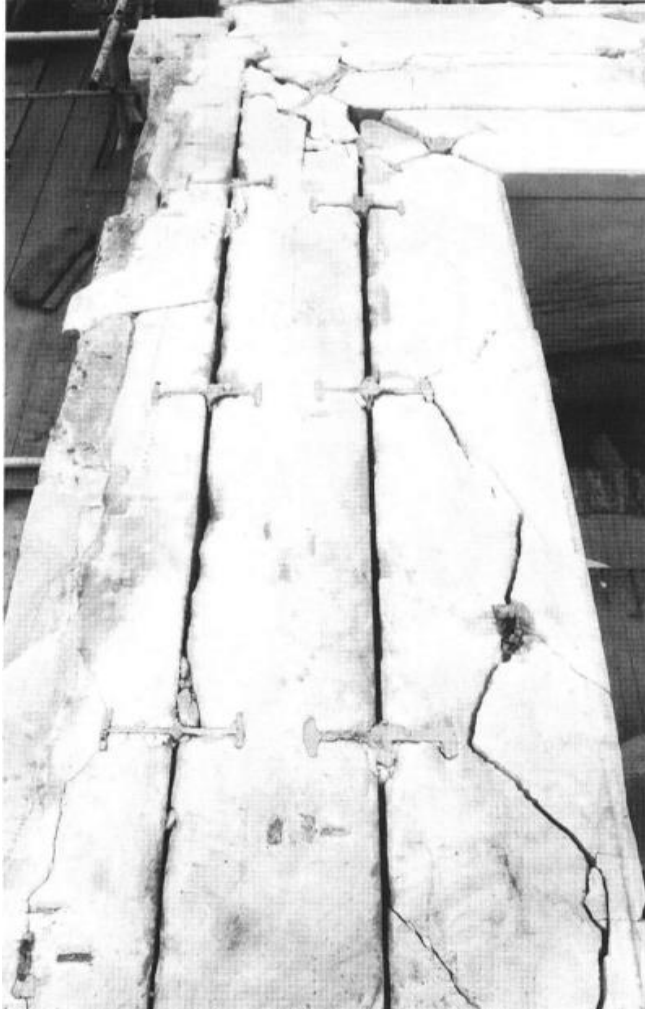
Εικόνα 51: Τα επιστύλια της ΝΔ γωνίας της δυτικής προστάσεως. Παρουσιάζουν εκτεταμένη θραύση στην περιοχή των συνδέσεων και σε ενδιάμεσες θέσεις. (Μελέτη Αποκαταστάσεως του Παρθενώνος, Τόμος 3β, Δομική Μελέτη Αποκαταστάσεως Οπισθονάου, Κ. Ζάμπας, ΥΠΠΟ, ΕΣΜΑ, Αθήνα 1994, σ. 9)
