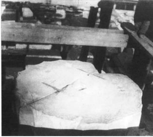
Εικόνα 103: Σιδηροί σύνδεσμοι συρραφής σε σπόνδυλο από το αρχείο Μπαλάνου. (Μελέτη Δομικής Αποκαταστάσεως της Βόρειας Όψης του Παρθενώνος, Κ.Ζάμπας, ΥΠΠΟ, ΕΣΜΑ, Αθήνα 2002, σ. 49)
