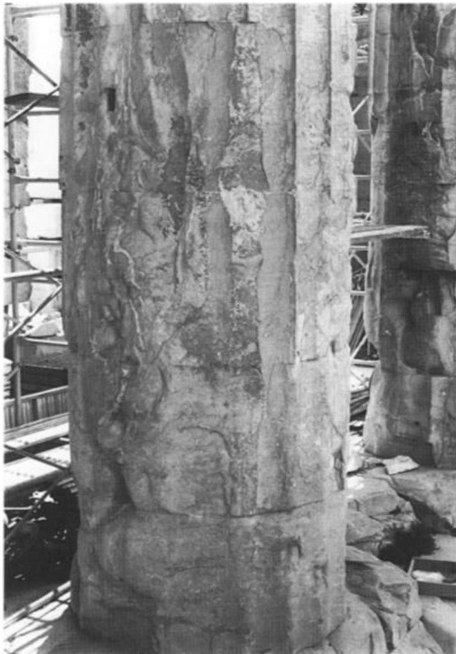
Εικόνα 74: Οι τέσσερις πρώτοι σπόνδυλοι του κίονα Ο.Κ 3 με νεότερα σφραγίσματα στα ρήγματά τους. (Μελέτη Αποκαταστάσεως του Παρθενώνος, Τόμος 3β, Δομική Μελέτη Αποκαταστάσεως Οπισθονάου, Κ. Ζάμπας, ΥΠΠΟ, ΕΣΜΑ, Αθήνα 1994, σ. 18)
