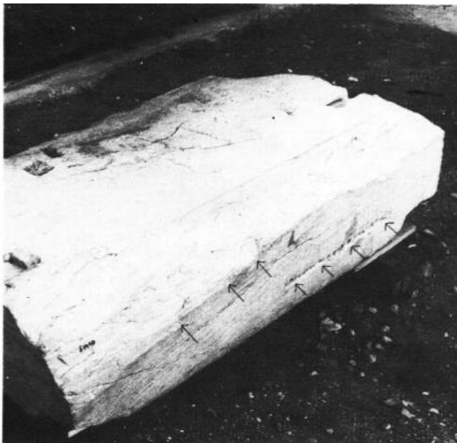
Εικόνα 145: Τεμάχιο με εμφανή ίχνη σφυροκοπημάτων. (Μελέτη Αποκαταστάσεως του Παρθενώνος, Τόμος 2α, Μ. Κορρές, Ν. Τογανίδης, Κ. Ζάμπας, Θ. Σκουλικίδης, κ.α., ΥΠΠΟ, ΕΣΜΑ, Αθήνα 1989, σ. 67)
