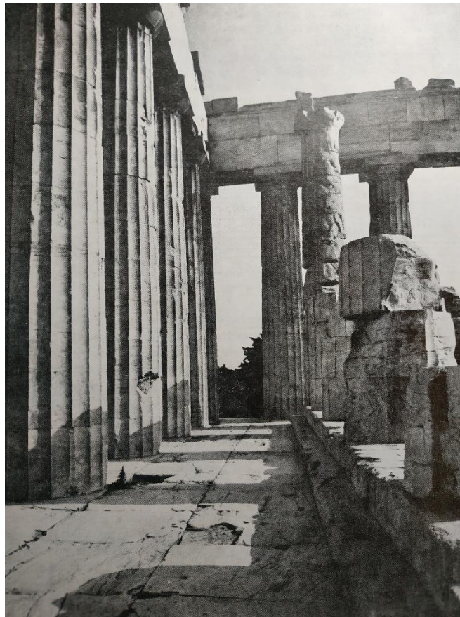
Εικόνα 44: Άποψη της κρηπίδας των κίωνων της πρόστασης με τον αναστηλωμένο ΝΑ κίονα στο βάθος. Στα αριστερά η ανατολική πλευρά του περιστυλίου, μεταξύ των δύο εκτείνεται το ευρύ ανατολικό περσό. (Η Αρχιτεκτονική του Παρθενώνος, Α. Κ. Ορλάνδος, Τόμος Β', Εν Αθήναις Αρχαιολογική Εταιρεία, Αθήνα 1977, εικ. 195)
