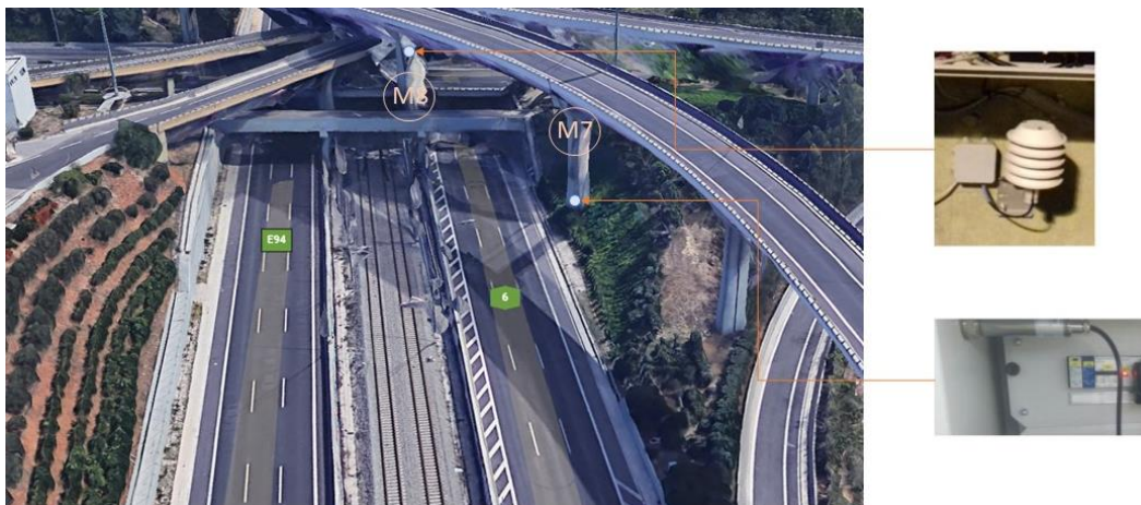
Σχήμα 5-5: Θέσεις εγκατάστασης αισθητήρων καταγραφής μετεωρολογικών Figure 5-5: Installation locations of meteorological recording sensors
