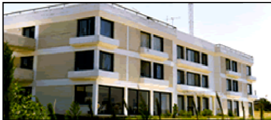
Εικόνα 2.1. Άποψη του υφιστάμενου κτιρίου.
