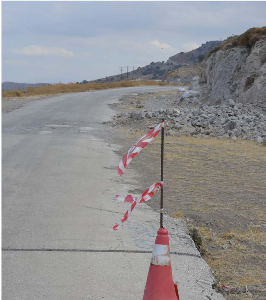
Εικ. 2: Νέος οδικός άξονας Καλλονής - Σιγρίου
