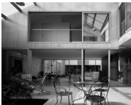
Κατοικία στο Bourdeaux, Lacaton & Vassal, 1999
