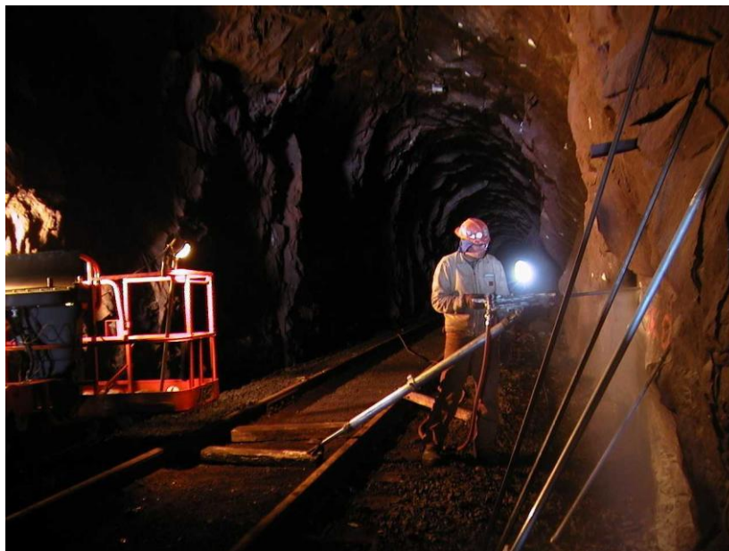
Εικόνα 3.6: Τοποθέτηση αγκυρίων βράχου
