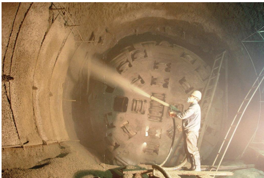
Εικόνα 3.4: Τοποθέτηση εκτ. σκυροδέματος μετά την προώθηση του μετώπου εκσκαφής
