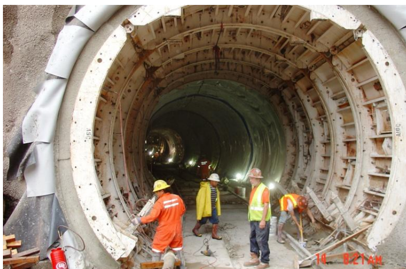
Εικόνα 3.10: Καλούπι σκυροδέτησης τελικής επένδυσης
