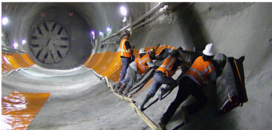
Εικόνα 3.7: Τοποθέτηση γεωφάσματος
