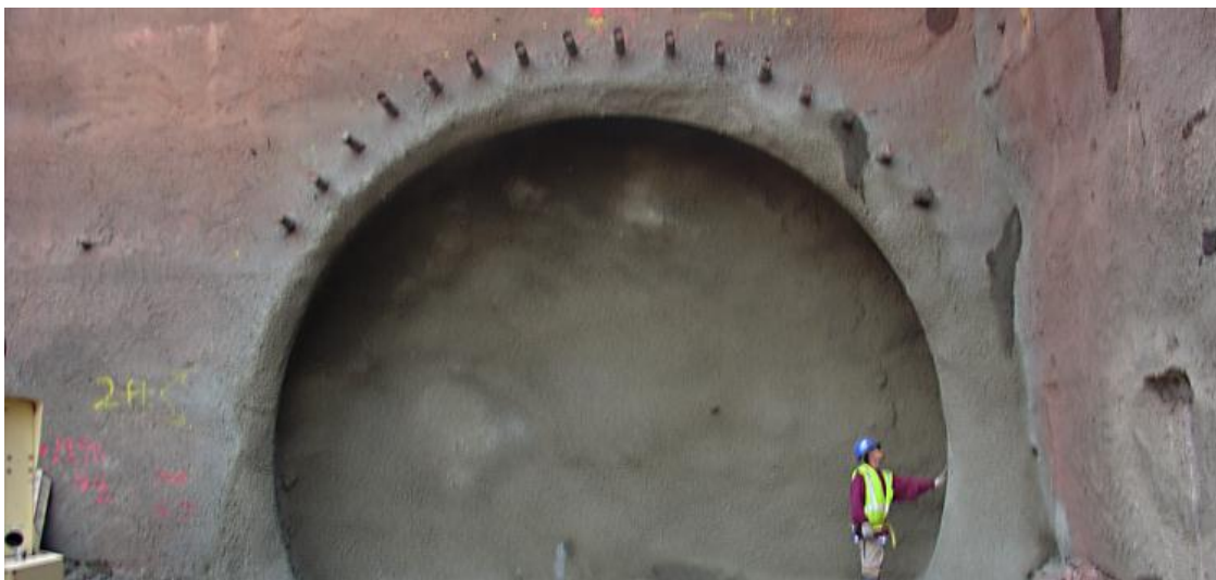
Εικόνα 3.3: Μέτρα αντιστήριξης του μετώπου εκσκαφής σήραγγας
