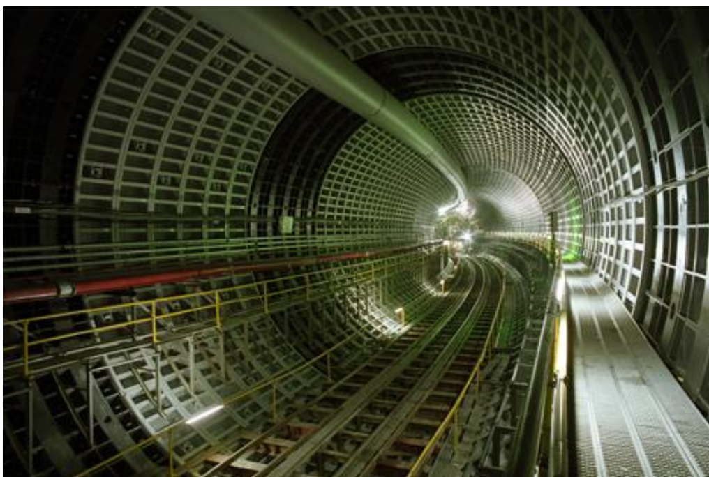
Εικόνα 3.9: Τελική επένδυση σήραγγας
