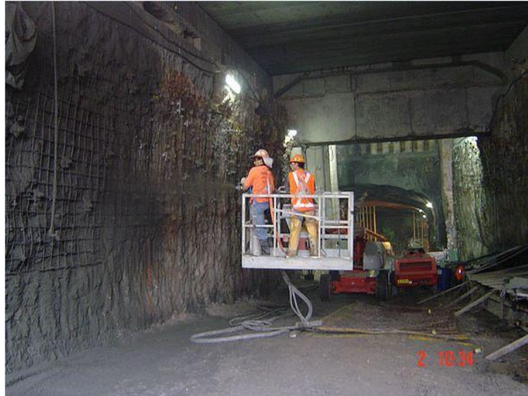
Εικόνα 3.5: Μεταλλικό πλέγμα σε συνδυασμό με εκτοξευόμενο σκυρόδεμα
