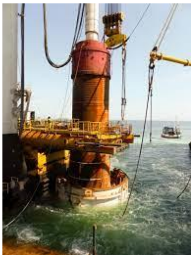
Σχήμα 1-27: Υδραυλικό σφουρί πασσάλων [17]
