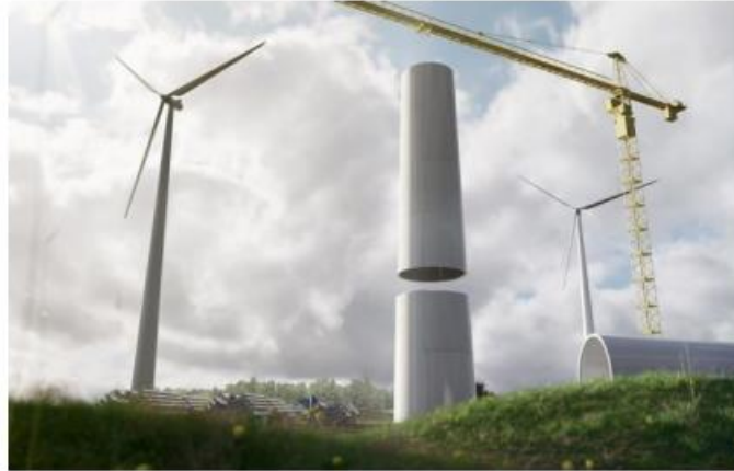
Σχήμα 1-14: Τοποθέτηση προκατασκευασμένων τμημάτων με γερανό [5]
