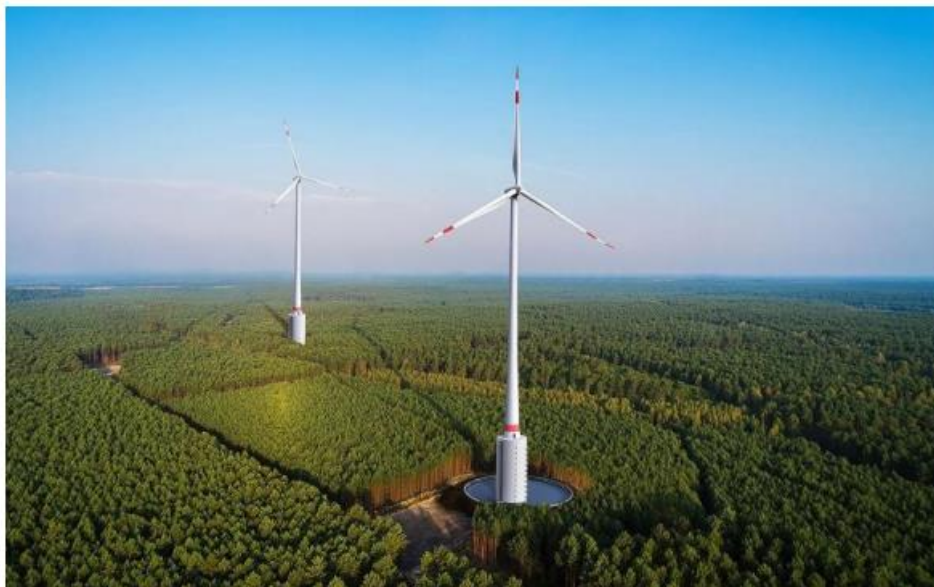
Σχήμα 1-18: Υβριδικός πύργος από σκυρόδεμα και χάλυβα [5]
