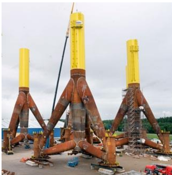
Σχήμα 1-29: Φορέας στήριξης μορφής τριπόδου [18]
