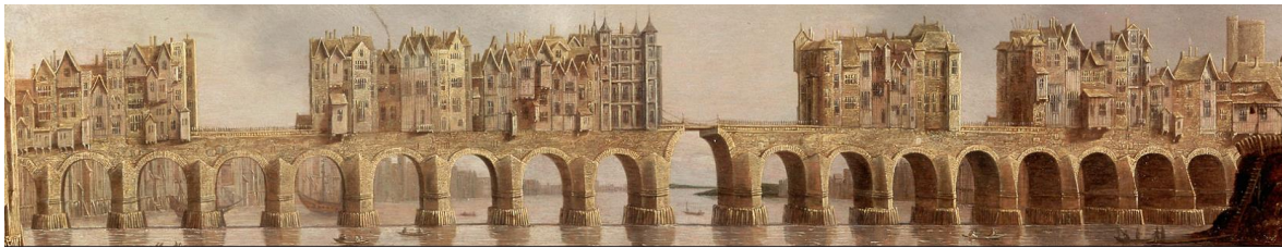
Σχήμα 3. Γέφυρα του Λονδίνου (Μεσαιωνικής περιόδου)
