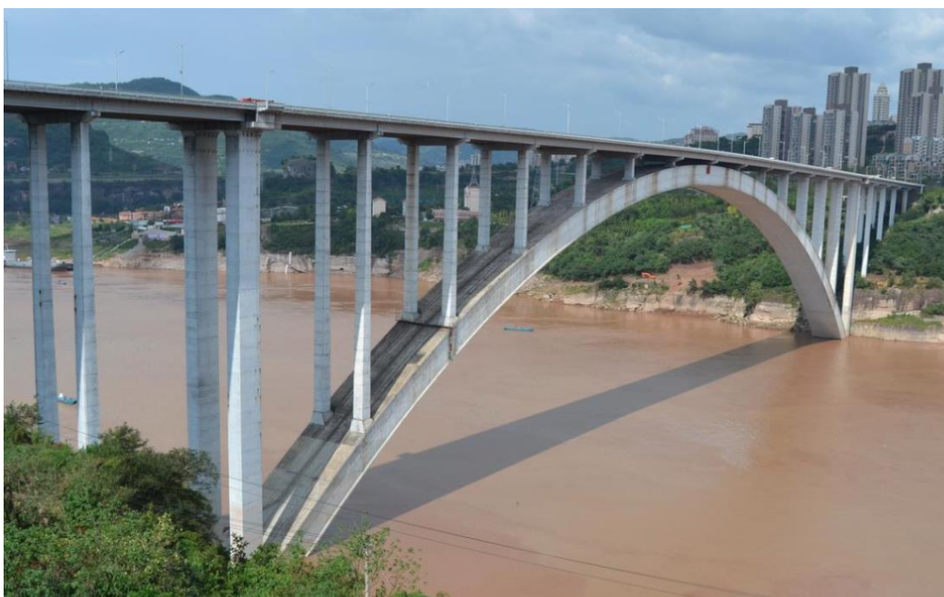
Σχήμα 9. Γέφυρα Wanxian (1997) από οπλισμένο σκυρόδεμα (τύπου Hennebique)
