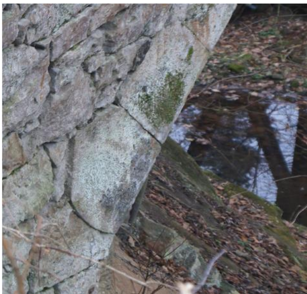
(α) Γέφυρα Langenhennersdorf (Γερμανία)
