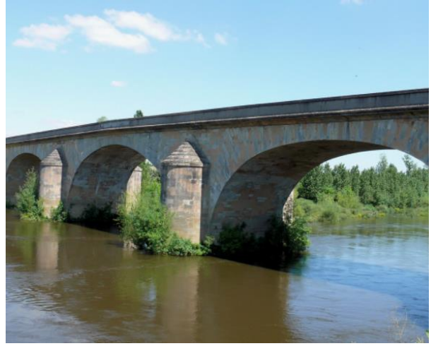
(β) Pont de Piles (1848)
