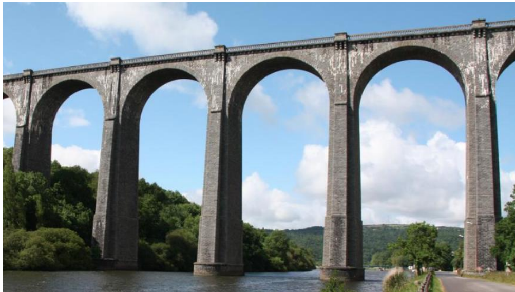
(ε) Viaduc de Port – Launay (1866)
