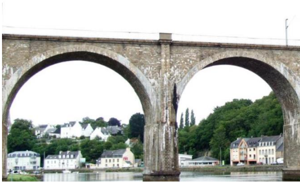
(γ) Pont de Hennebout (1866)
