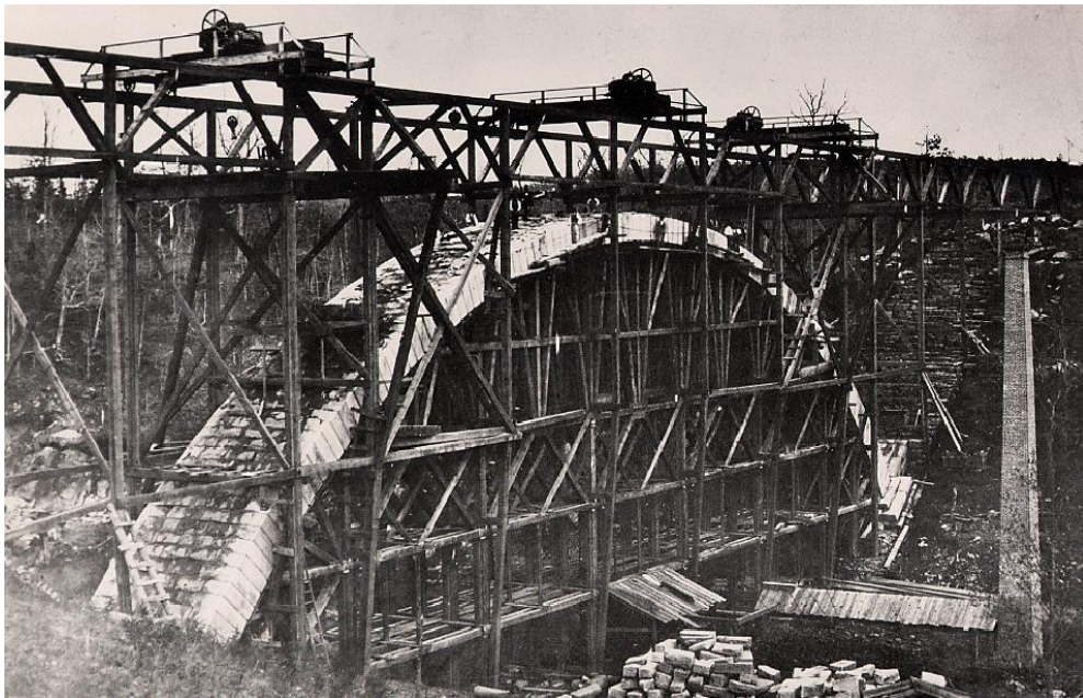
Σχήμα 55. Φάση κατασκευής κύριου τόξου
