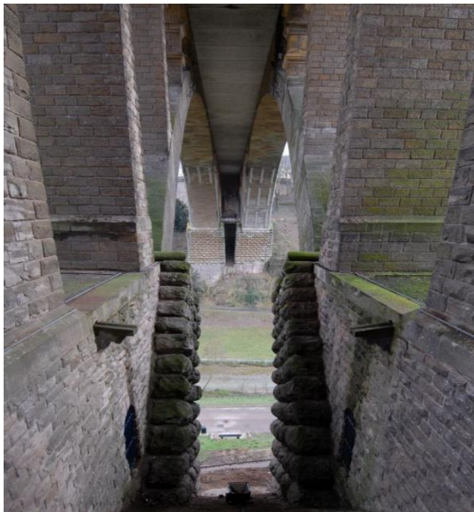
Σχήμα 38. (α) Διάταξη σύνδεσης τόξου – ακροβάθρων, (β) τοξοστοιχίες άνωθεν κεντρικού τόξου
