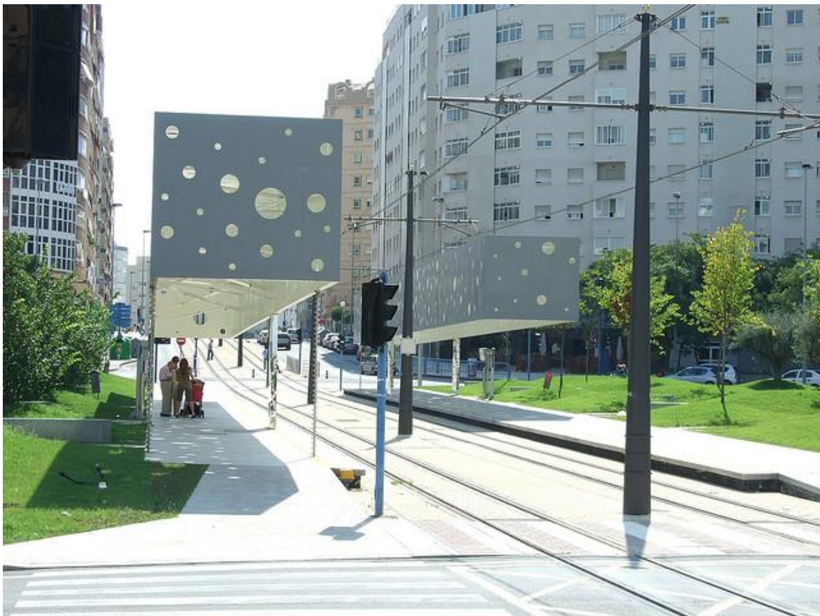
Εικόνα 1.6: Tram stop, Alicante, Spain, Πηγή: www.mimoa.eu
