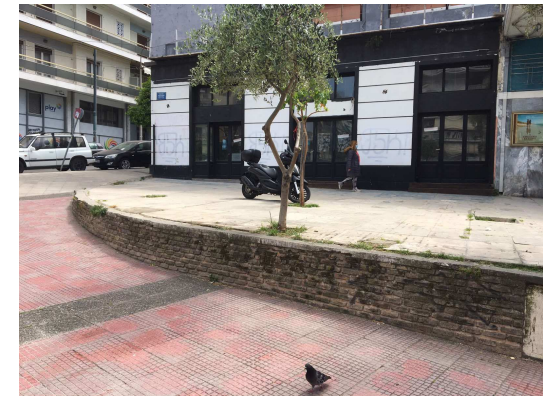
Εικόνα 24: Άποψη πεζοδρομίου «Πάλας» στην οδό Ιφικράτους – Υφιστάμενη Κατάσταση
