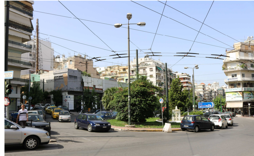
Εικόνα 43: Άποψη κινηματογράφου «Πάλας» (ΥΦΙΣΤΑΜΕΝΗ ΚΑΤΑΣΤΑΣΗ)
