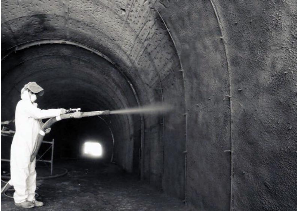
Εικόνα 3-5: Διάστρωση εκτοξευόμενου σκυροδέματος (Πηγή: http://www.mpampalis-adiataraktikopi.gr/index.php?l=el )
