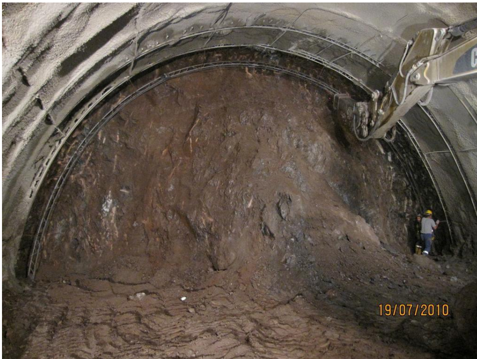
Εικόνα 3-7: Μεταλλικά πλαίσια κατηγορίας 1 (Πηγή : www.depositary.kallipos.gr )
