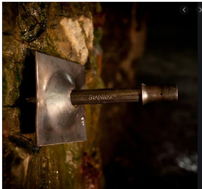
Εικόνα 3-6: Αγκύριο Swellex (Πηγή : https://www.epiroc.com/en-za )
