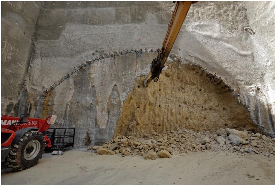
Εικόνα 3-8: Δοκοί προπορείας (Forepoling), που χρησιμοποιήθηκαν για τη σήραγγα του τμήματος Α της περιοχής έρευνας (Πηγή: AVAX)
