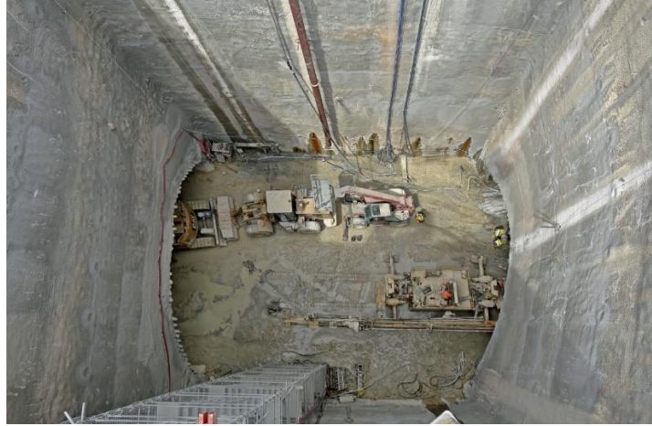
Εικόνα 2-3: Πανοραμική φωτογραφία από το φρέαρ Δεληγιάνη όπου εξήχθη το TBM (Πηγή: AVAX)
