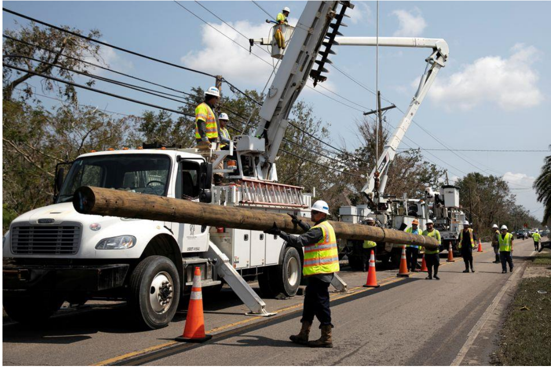
Εικόνα 3. Συνεργεία αποκατάστασης πυλώνων διανομής μετά τον τυφώνα "Ida"
