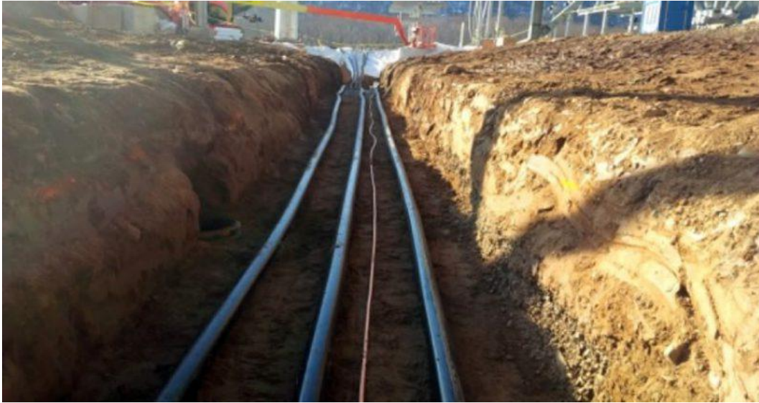
Εικόνα 6. Υπόγειες γραμμές ηλεκτρικής ενέργειας
